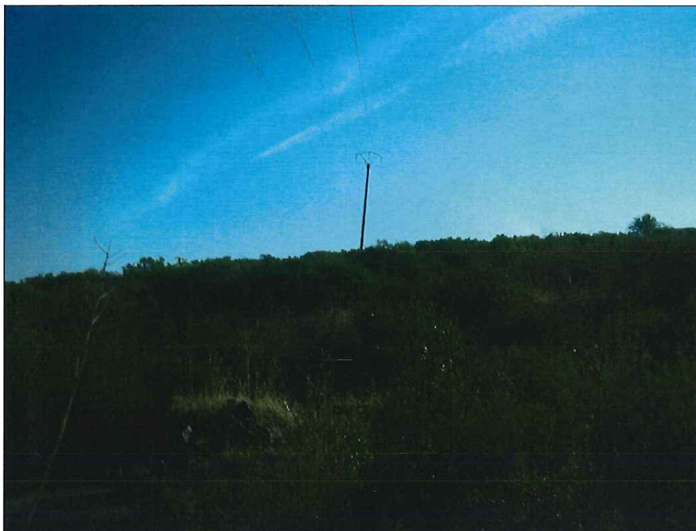
Línea eléctrica de la depuradora existente. Bajo la misma se ha proyectado la apertura de una línea cortafuegos (LC01) en la que se eliminará completamente toda la vegetación con medios mecánicos
