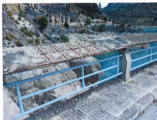
Estado actual del hormigón del pretil de coronación
