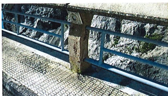
Estado actual del hormigón del pretil de coronación
