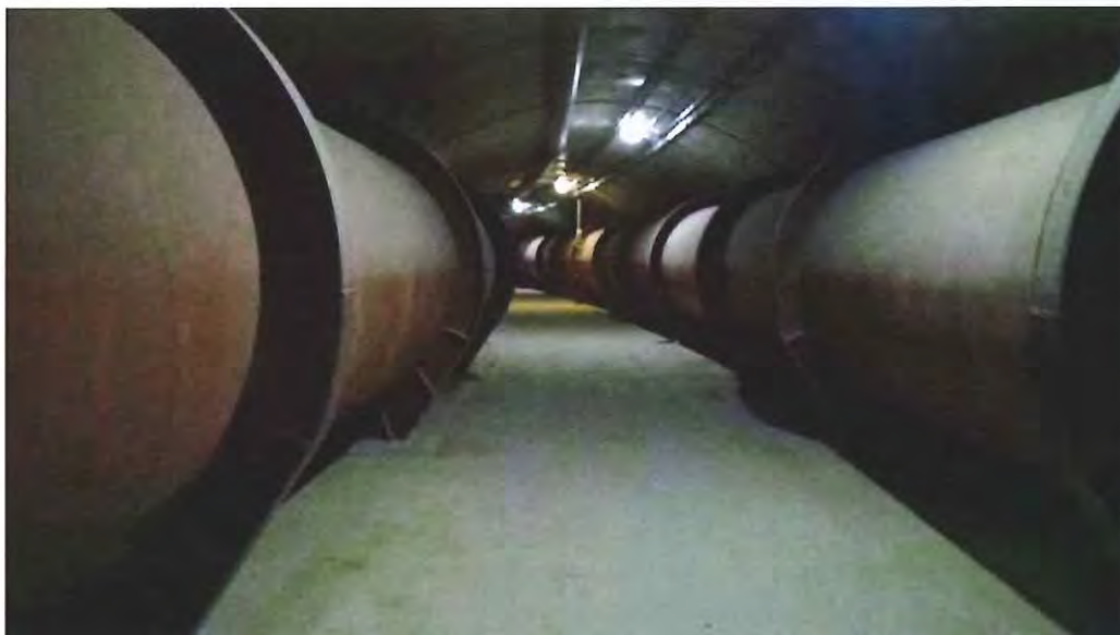
Vista general del túnel de desvío donde se sitúan las dos conducciones forzadas DN-2000
