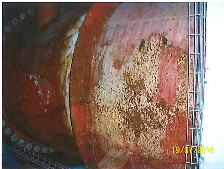
Estado de las conducciones a la salida de la cámara de válvulas del desagüe de fondo
