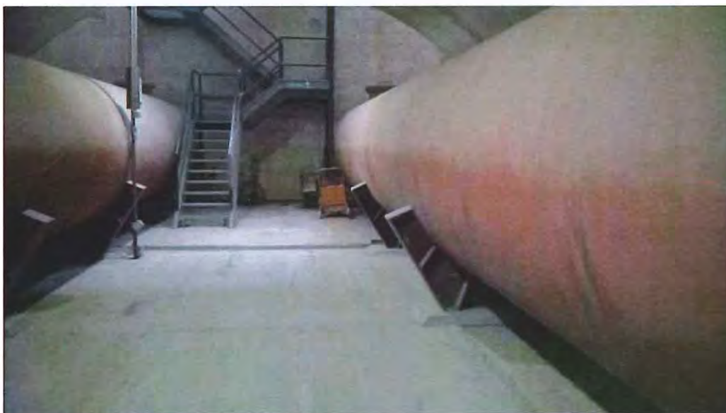
Escalera de acceso al túnel de desvío desde la estructura de salida
