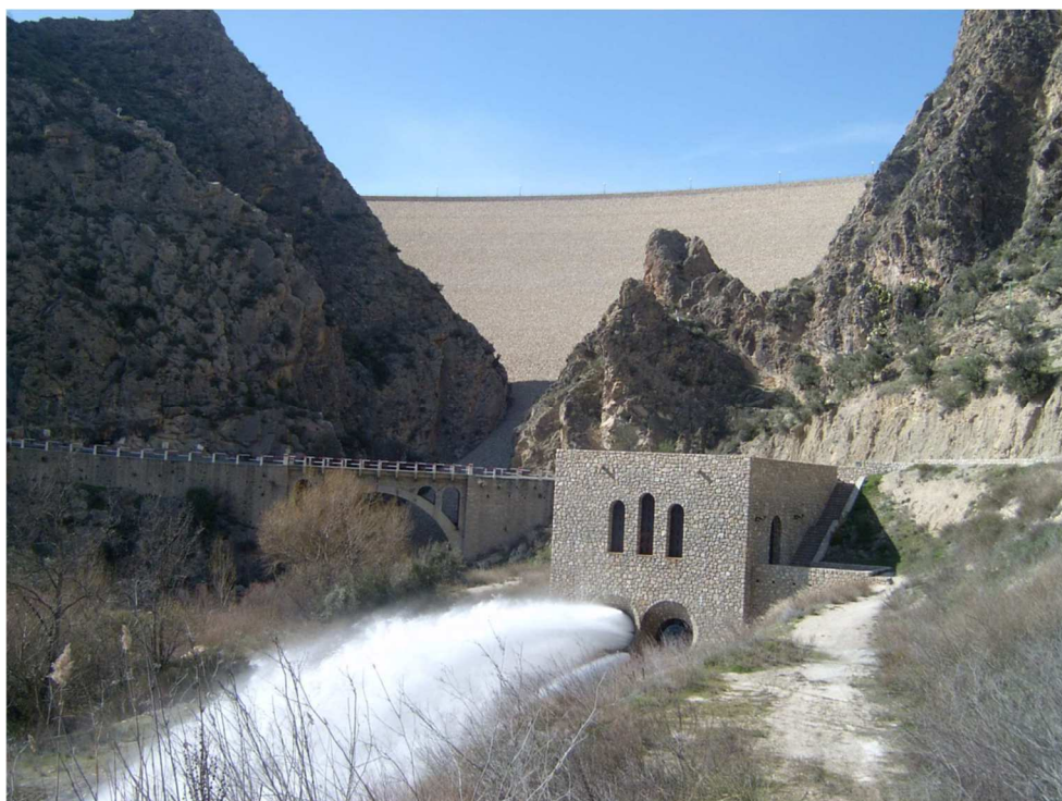
Ilustración 5. Desagüe de la presa de El Portillo.
