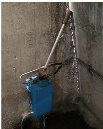
Ilustración 9. Bomba oleohidráulica de accionamiento manual.
