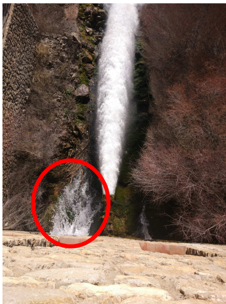
Ilustración 12. Fugas de agua del desagüe de fondo izquierdo.
