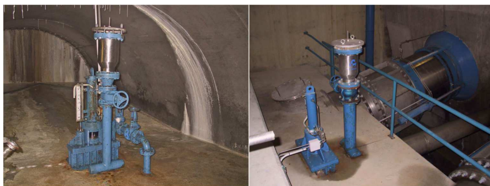
Ilustración 7. Válvulas Bureau de control del desagüe ecológico.
