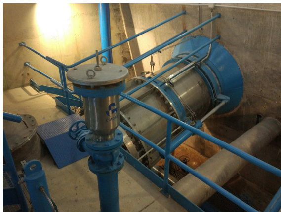
Ilustración 11. Válvula Howell Bungler izquierda del desagüe de fondo.
