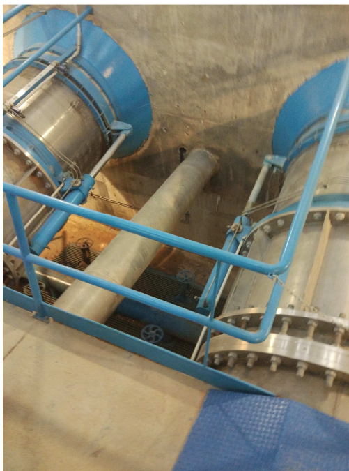
Ilustración 10. Detalle de conducto del desagüe ecológico
