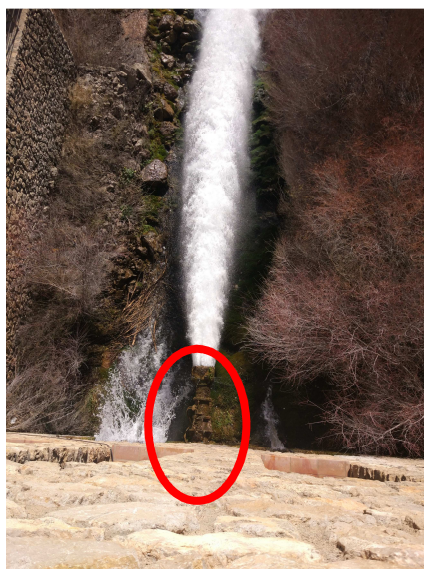
Ilustración 8. Válvula Howell Bunger de accionamiento interno. Desagüe ecológico.
