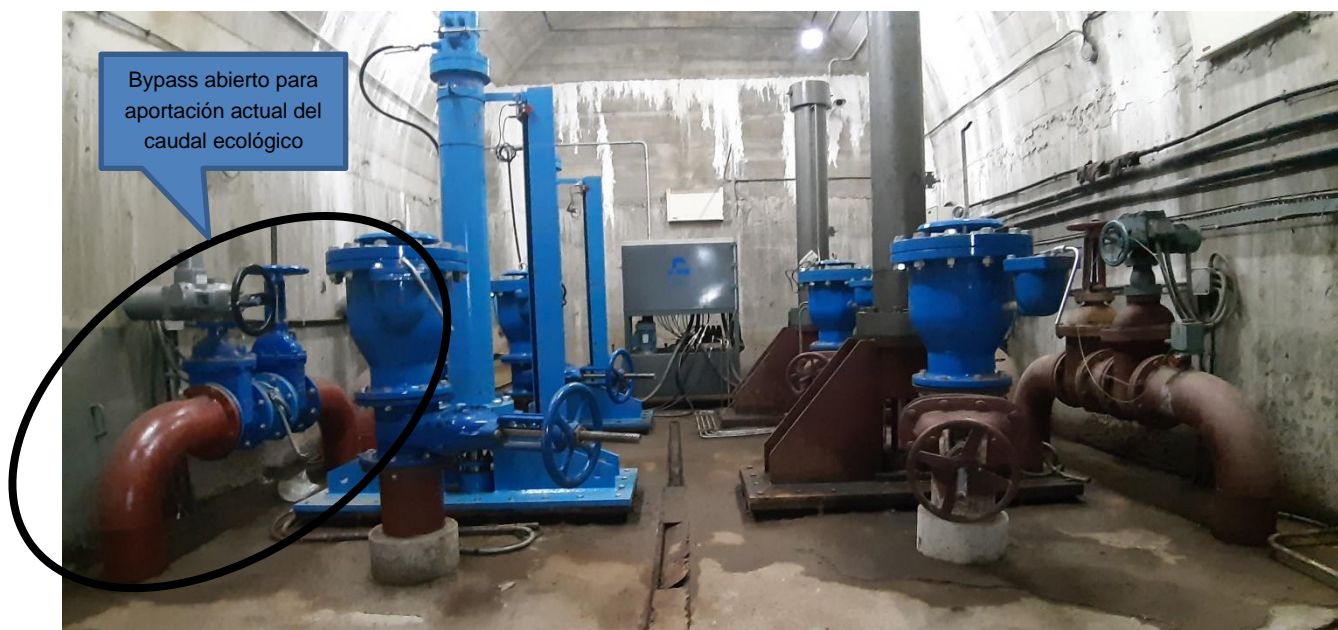
Vista general de la cámara de válvulas de los desagües de fondo y tomas (La valvulería y conductos de la línea derecha han sido totalmente reemplazados, está pendiente la línea izquierda)
