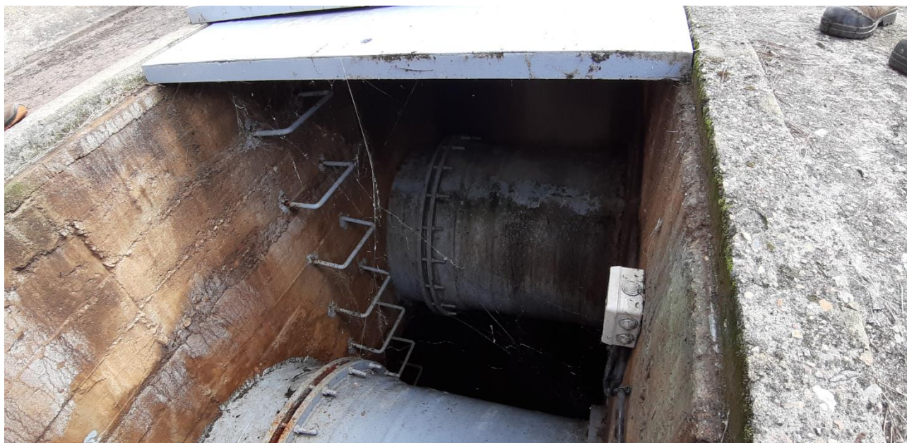
Arqueta del desagüe intermedio bajo la cámara de ventímetro. En la visita se planteó la variante de hacer la conexión desde esta arqueta y salida directa al cuenco por el exterior, planteando alguna solución para salvar el paso a las escaleras
