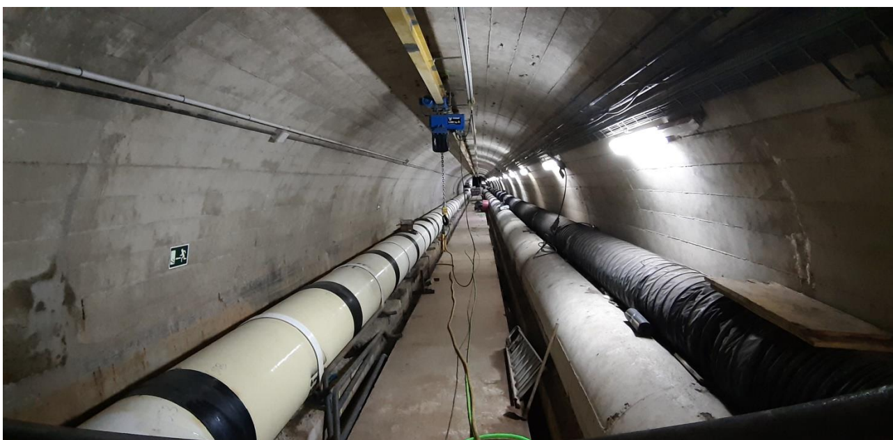
Vista general de galería con las dos líneas de los desagües de fondo y tomas
