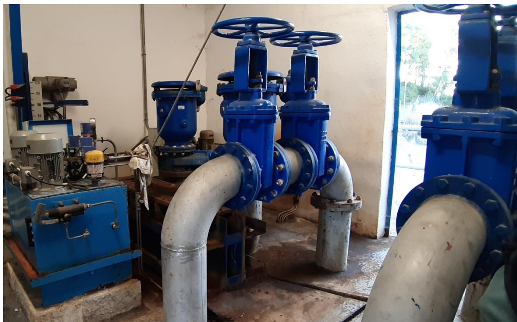
Bypass de los desagües de fondo
