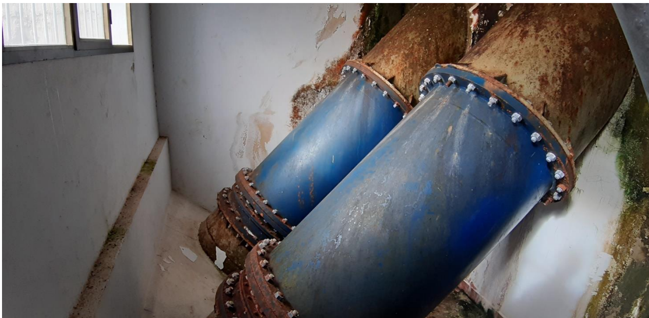
Conductos del desagüe intermedio en cámara de venturímetro, desde donde se proponía realizar la conexión de un nuevo conducto
