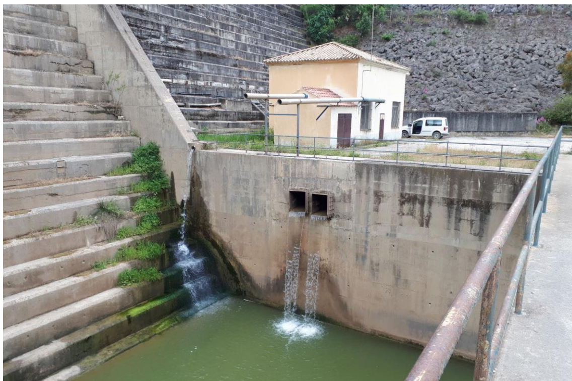
Salida original de los desagües de fondo. En el año hidrológico 2019/20 se ha cambiado el trazado
