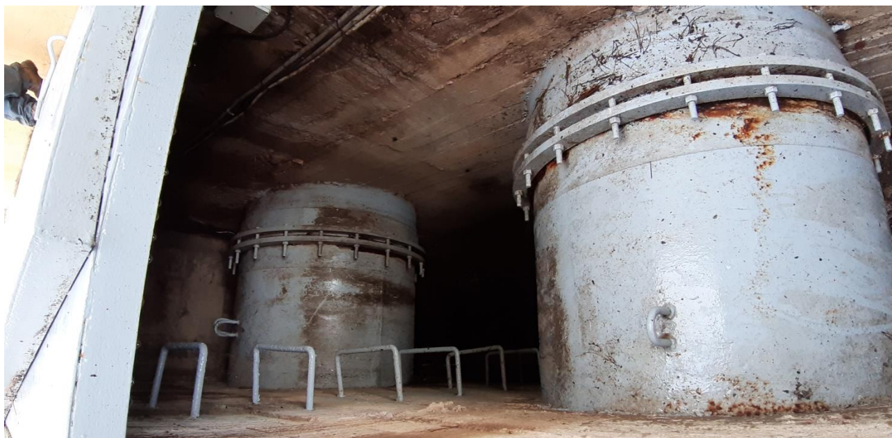
Conductos del desagüe intermedio a los que se conectará el nuevo conducto que discurrirá enterrado.
