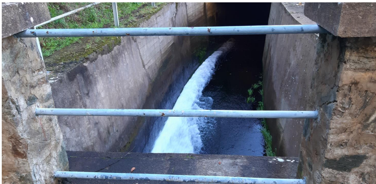
Aportación actual del caudal ecológico por el canal de descarga, con la abertura comentada
