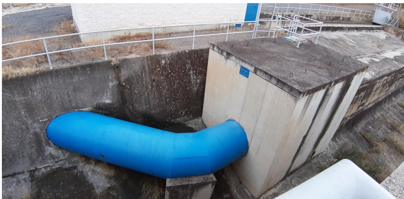
Conducto de interconexión de la presa con el Canal del Bajo Guadalquivir antes de entrar en arqueta
