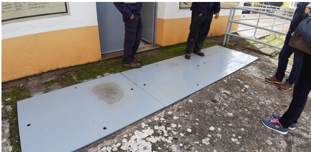
Arqueta delante de la cámara de válvulas del desagüe intermedio, desde el que está previsto realizar la conexión de un nuevo conducto.
