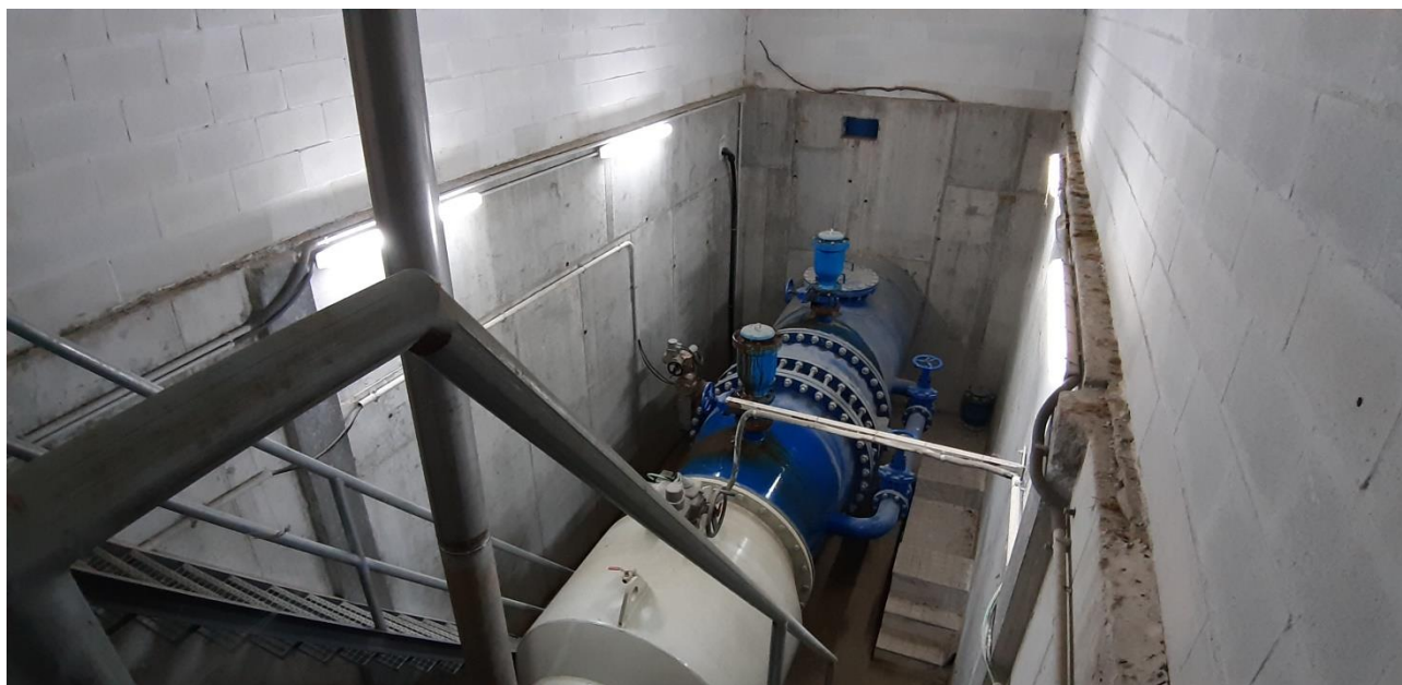
Cámara de válvulas de la toma de riego, con las válvulas mariposa de resguardo y Larner Johnson de regulación.
