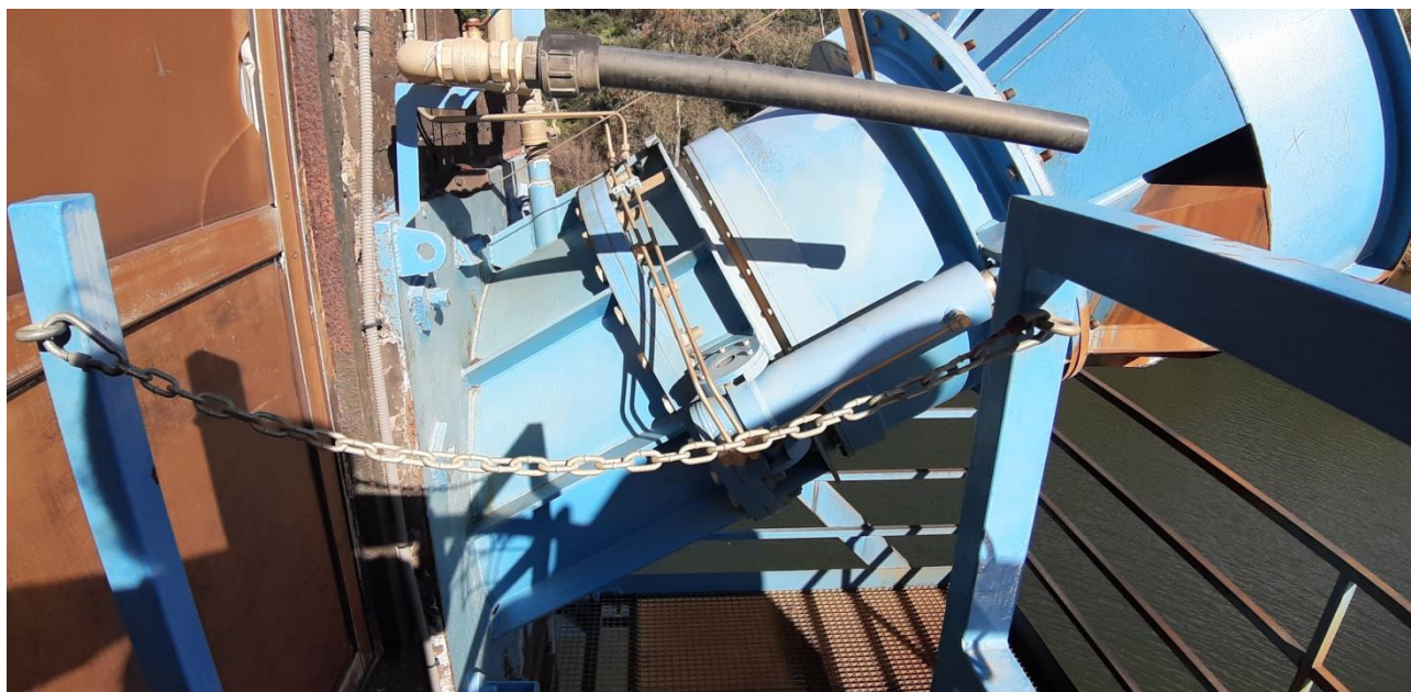
Válvula de regulación (Howell Bunger) de la toma izquierda
