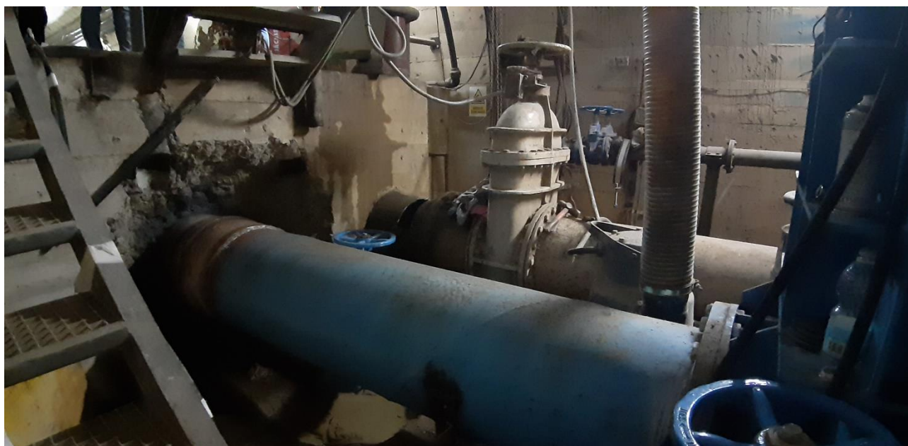
Conducciones del desagüe de fondo (línea derecha nueva, línea izquierda pendiente)
