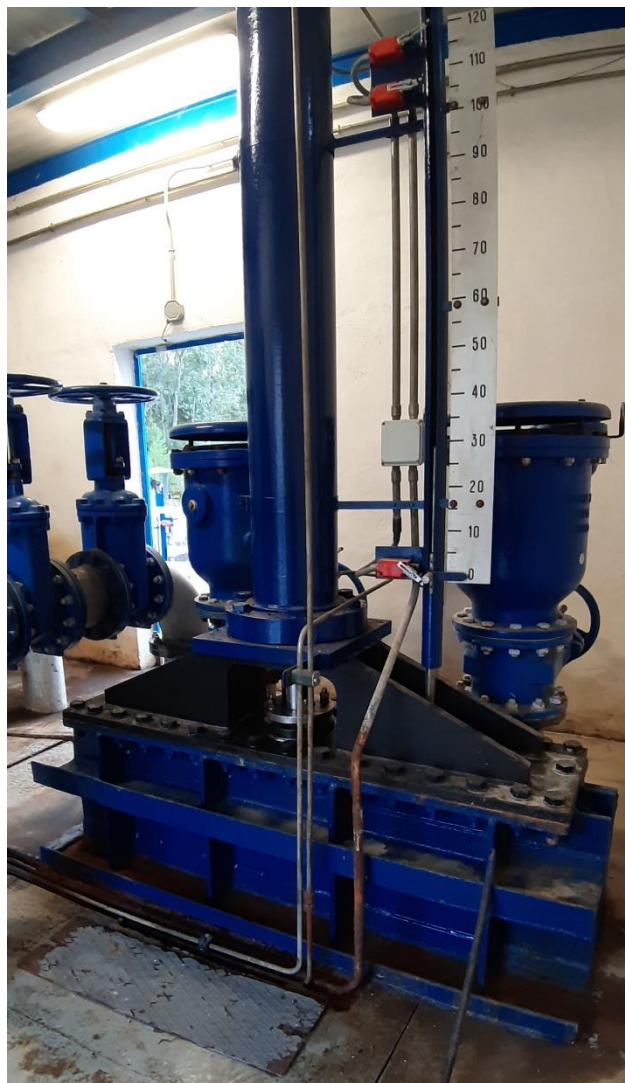
Válvulas de guarda intermedias y ventosas de las mismas en desagüe de fondo secundario, izquierda, y principal, derecha.
