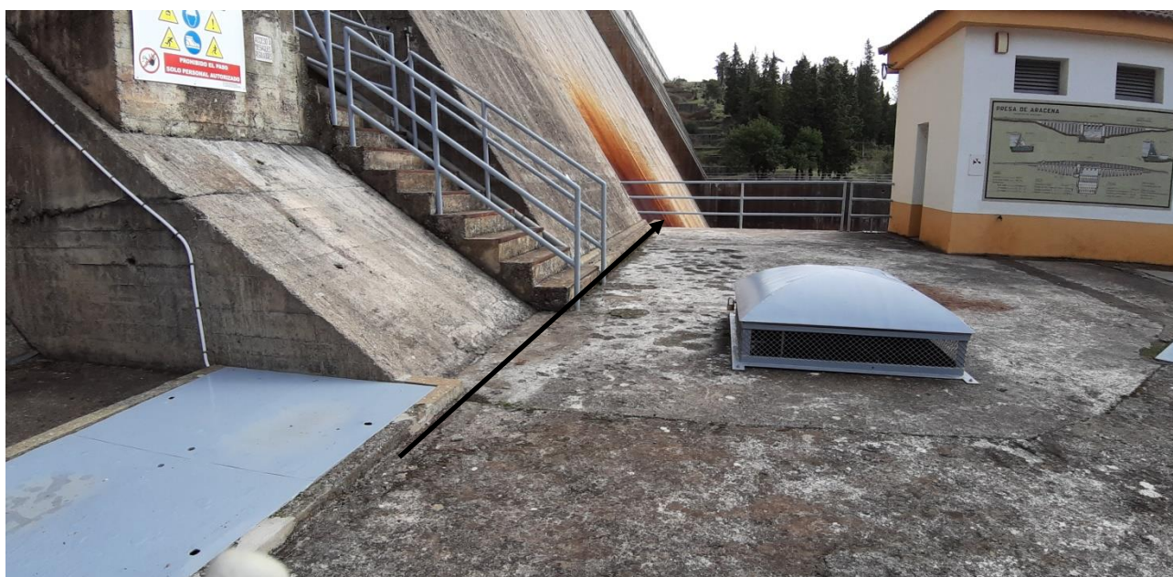
Arqueta del desagüe intermedio bajo la cámara de ventímetro. En la visita se planteó la variante de hacer la conexión desde esta arqueta y salida directa al cuenco por el exterior, planteando alguna solución para salvar el paso a las escaleras
