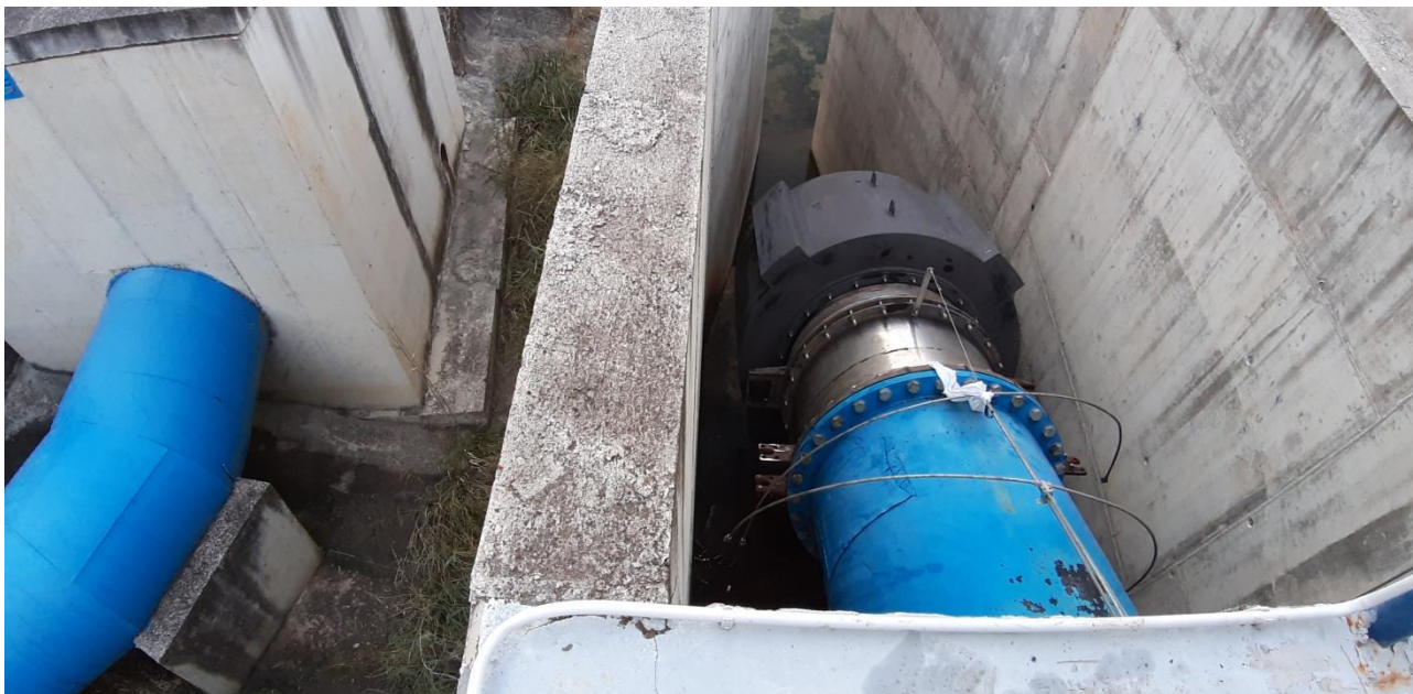
A la izquierda, conducto de interconexión con el Canal del Bajo Guadalquivir y a la derecha, válvula de regulación, Howell Bunger, del desagüe de fondo secundario.
