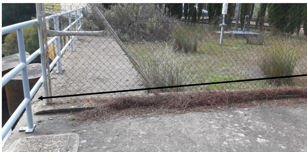
Zona donde, aprovechando el menor espesor del muro, se dará salida al cuenco de la presa.
