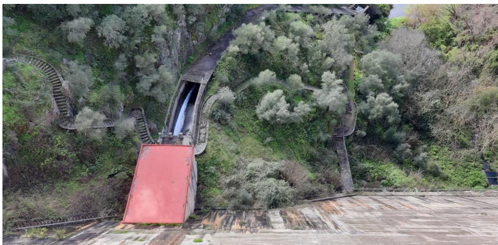
Vista general del comienzo de canal de descarga del desagüe regulador, la cámara de válvulas y de la margen izquierda del pie de presa
