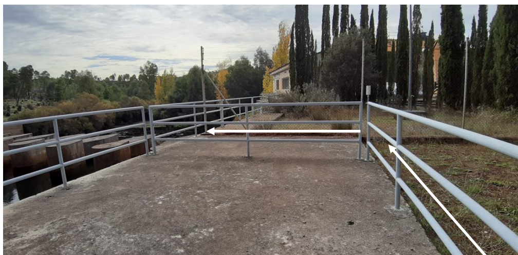
Conductos del desagüe intermedio a los que se conectará el nuevo conducto que discurrirá enterrado.
