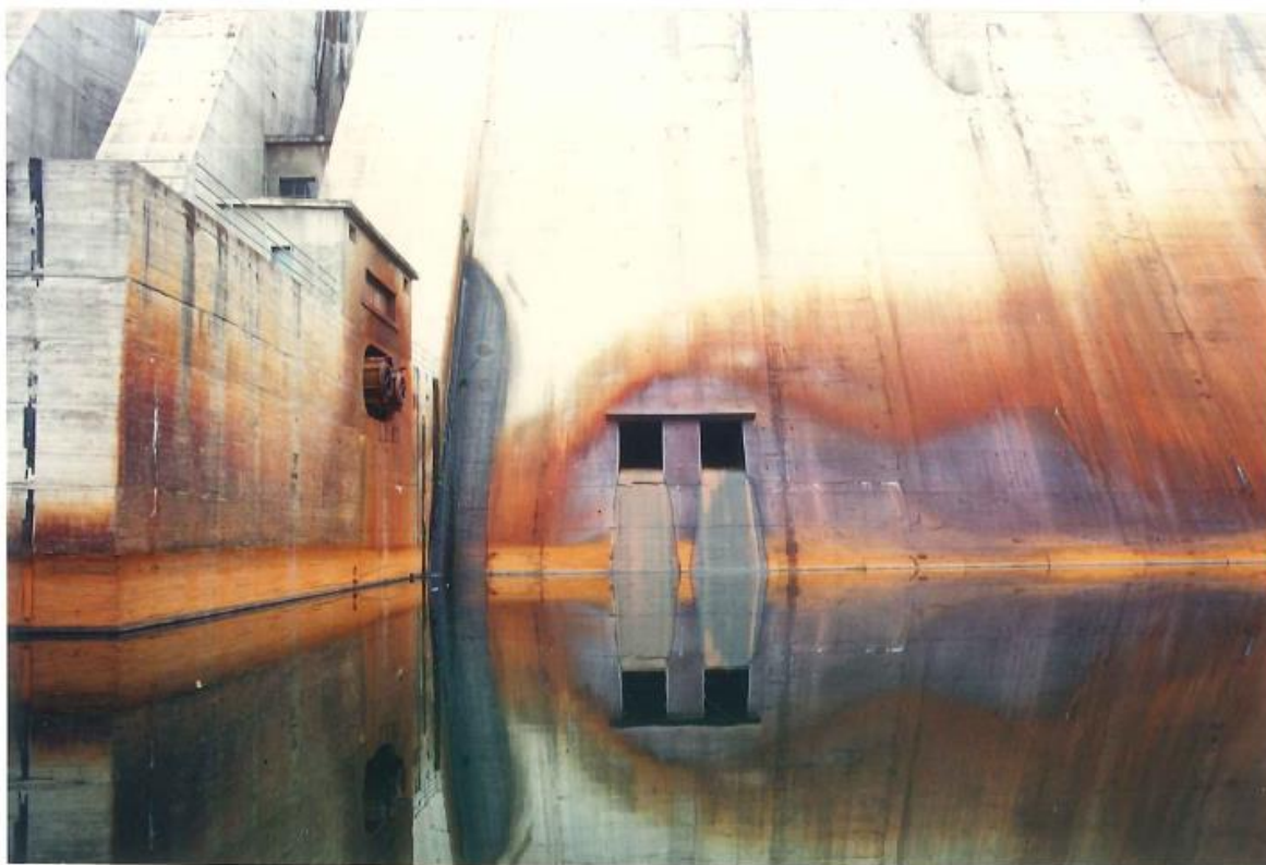
Salida del desagüe de fondo
