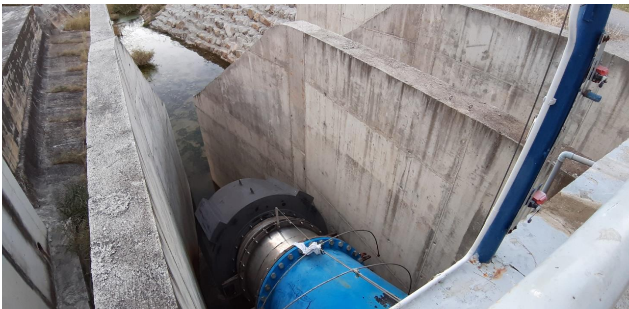
Vista de la salida de la conducción del desagüe de fondo secundario y del cuenco amortiguador de los desagües de fondo
