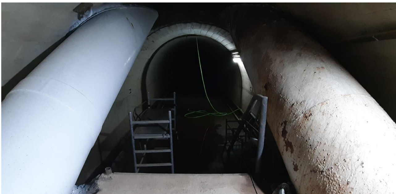
Entrada de los conductos de desagüe de fondo y tomas en galería desde la cámara de válvulas de seguridad
