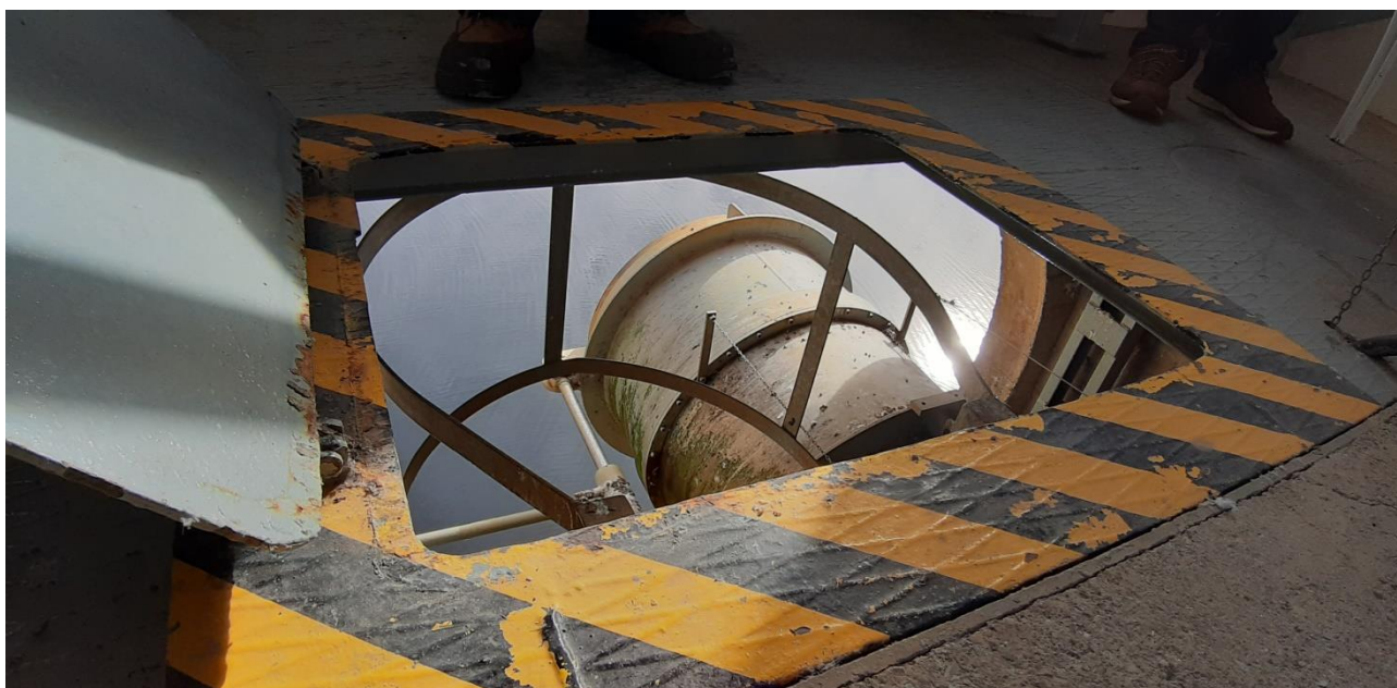
Vista de las compuertas de salida del desagüe intermedio desde la cámara de válvulas. Desde donde se proponía colocar un conducto de desvío para el desagüe ecológico. Las dificultades de acceso frente a la otra propuesta descartan esta opción.
