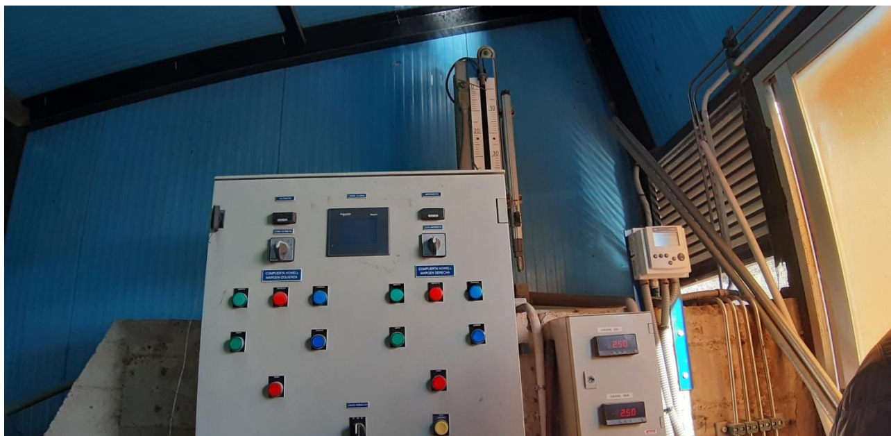
Cuadro de control de las compuertas en caseta
