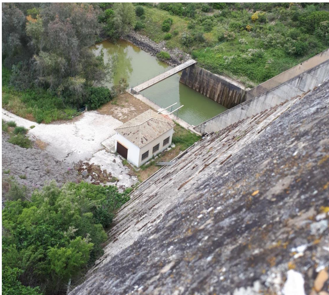
Vista general del pie de presa aguas abajo con la caseta de válvulas y el cuenco amortiguador
