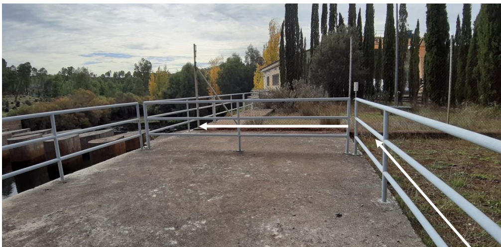
Trazado de la zanja del nuevo conducto para el caudal ecológico hasta salida al cuenco
