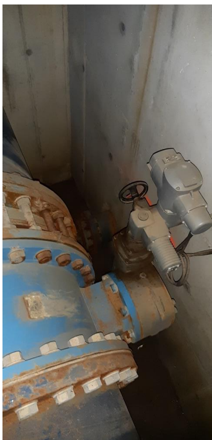
Interior de la arqueta de la conducción de interconexión de la presa con el Canal del Bajo Guadalquivir que aloja la válvula mariposa.
