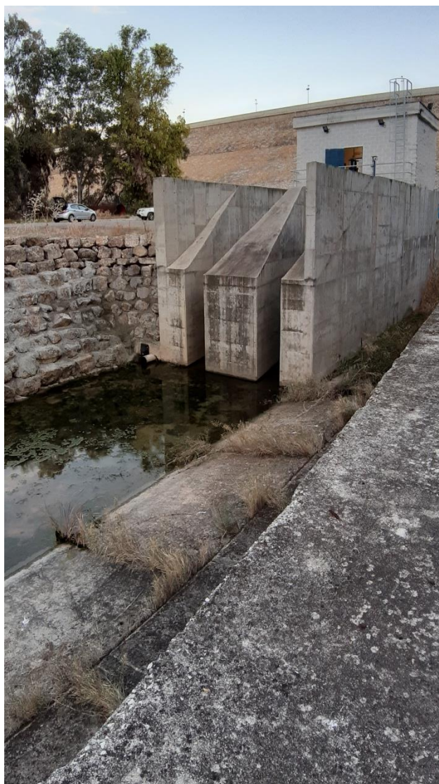
Cuenca amortiguador de los desagües de fondo
