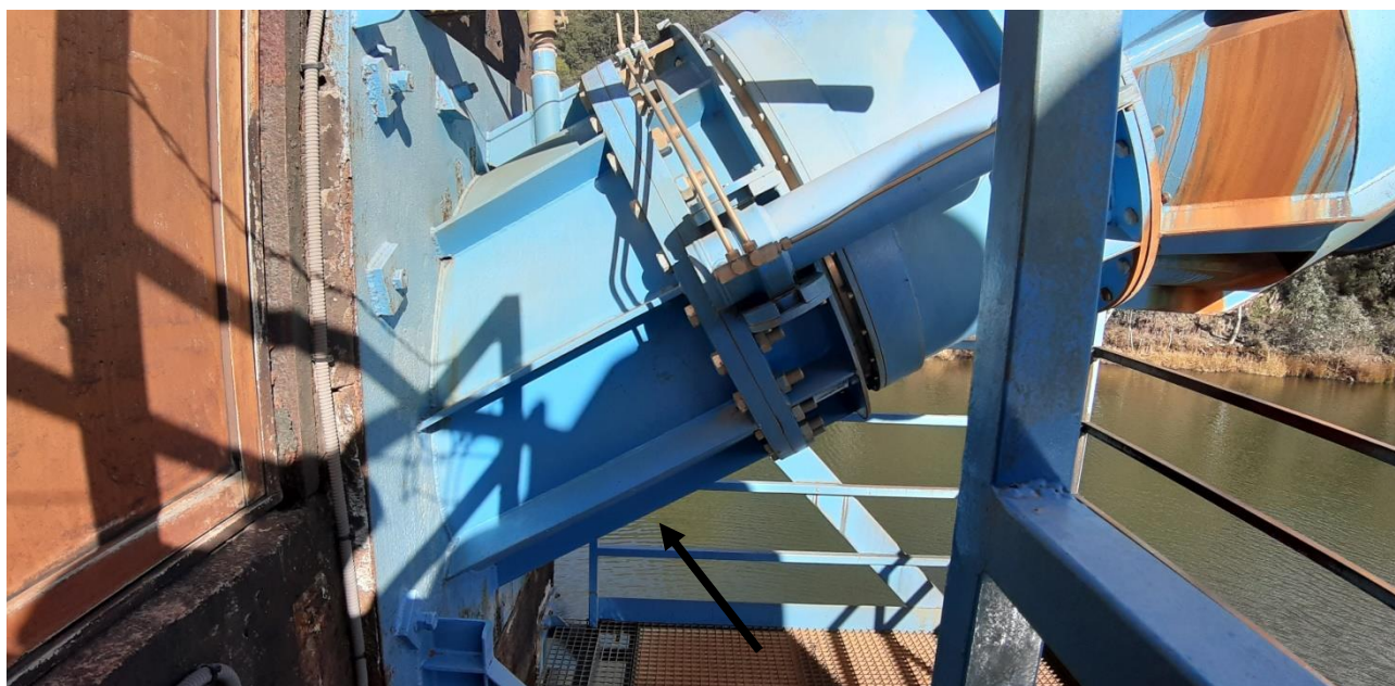
Detalle de la zona de conexión del nuevo conducto para el caudal ecológico
