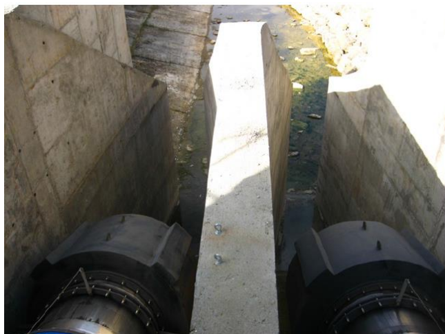
Vista de las válvulas Howell-Bunger de salida
