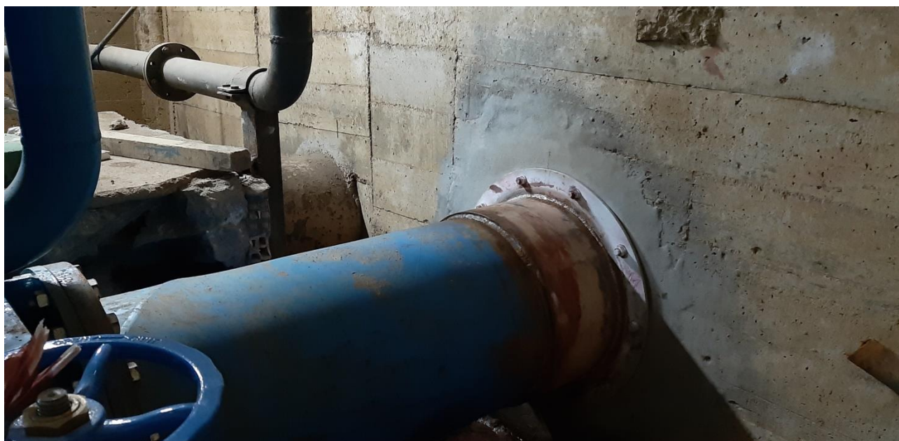
Detalle salida del conducto del desagüe de fondo al exterior (cauce inundado)
