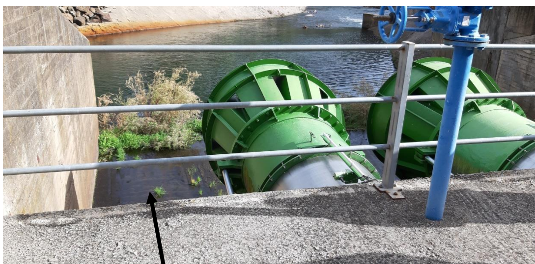
Compuertas de regulación del desagüe de fondo
