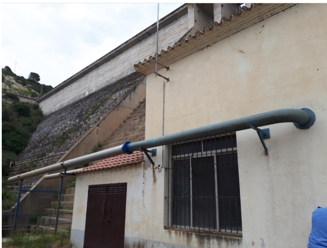
Aireación de las válvulas
