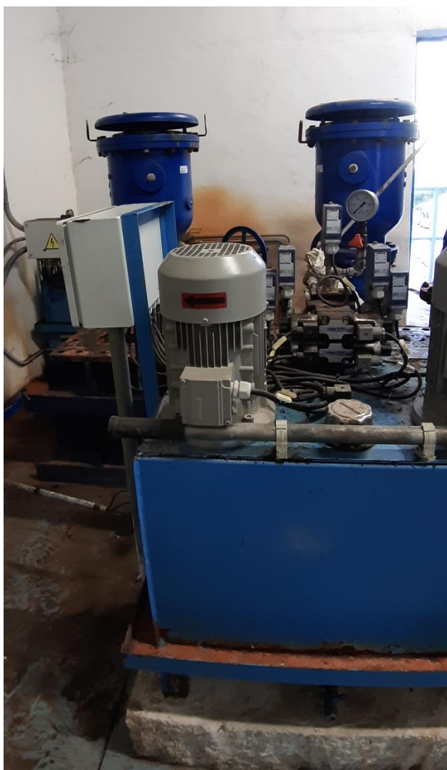
Válvulas de guarda intermedias y ventosas de las mismas en desagüe de fondo secundario, izquierda, y principal, derecha.
