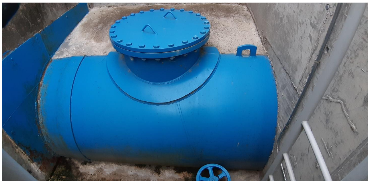
Boca de hombre en conducto de desagüe de fondo principal
