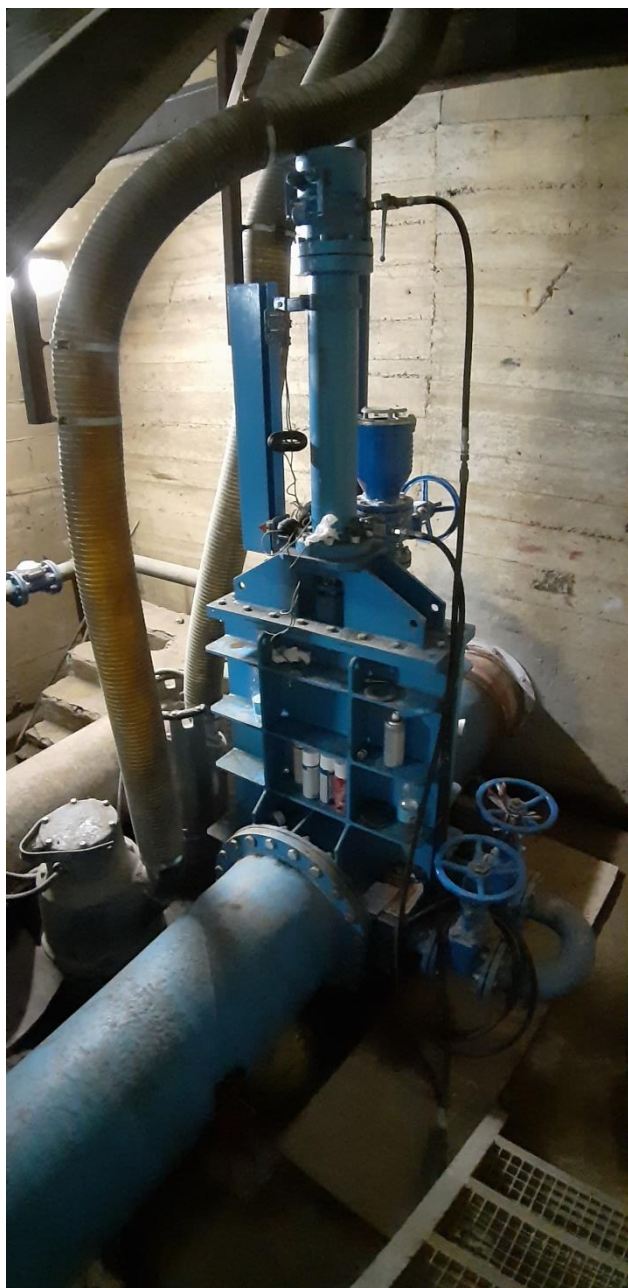
Vista general de la compuerta Bureau de regulación del desagüe fondo y del conducto.
