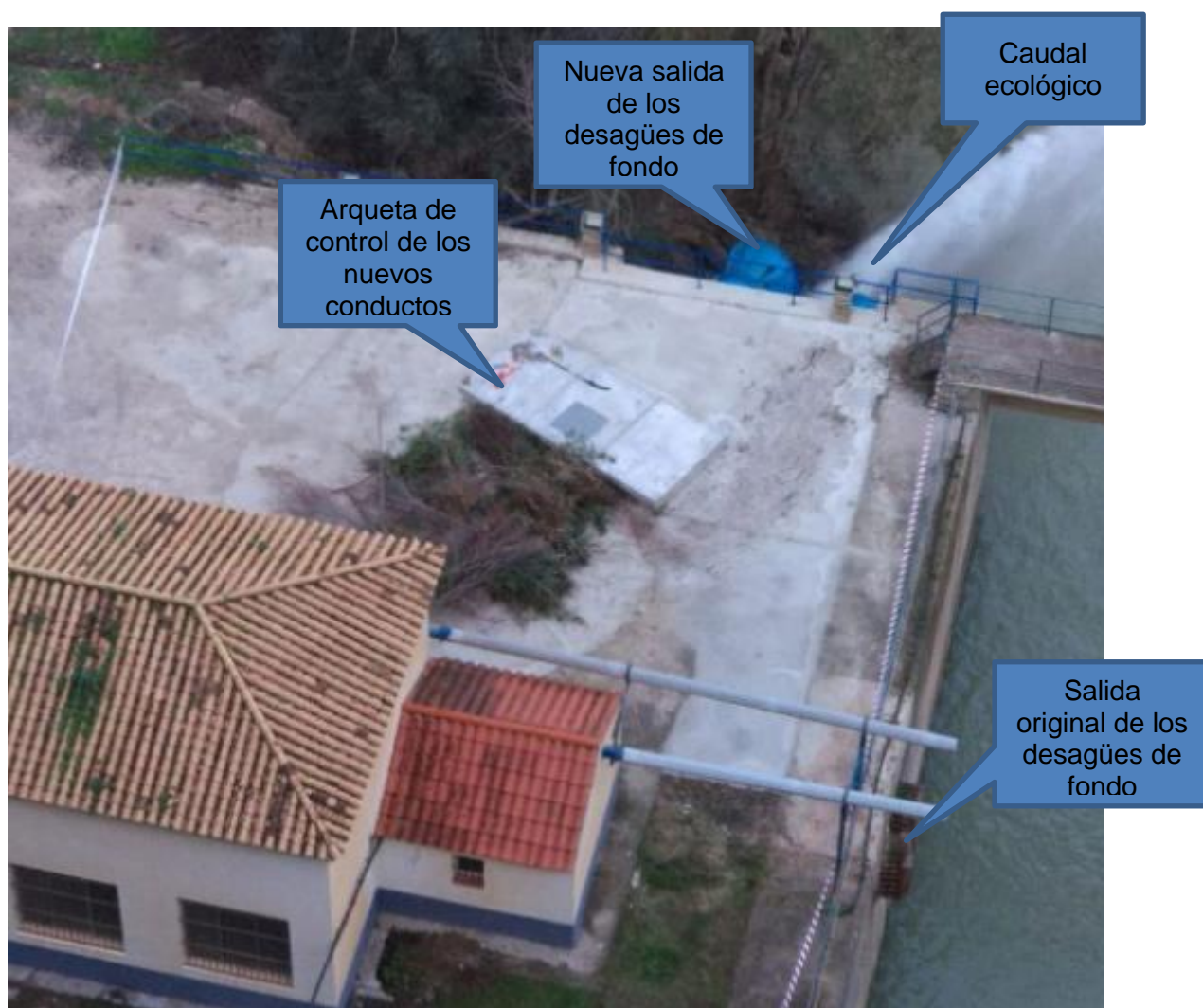
Nuevo trazado de los conductos del desagüe de fondo.
