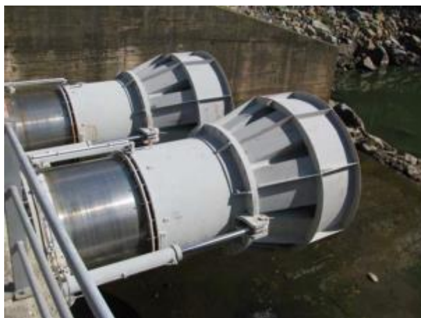
Detalle de salida de las tuberías del desagüe de fondo
