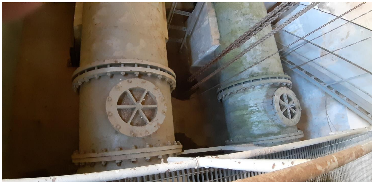
Vista de la boca de hombre en los dos conductos del desagüe regulador
