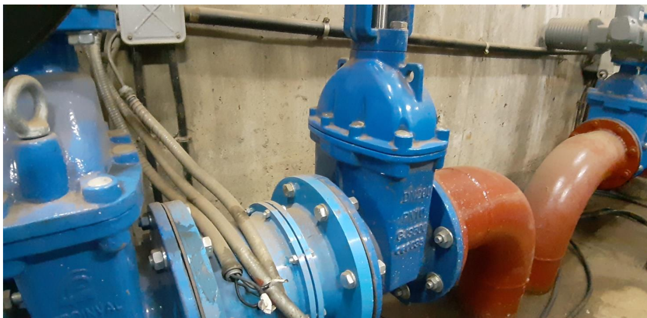
Detalle del Bypass por el que se aporta actualmente el caudal ecológico
