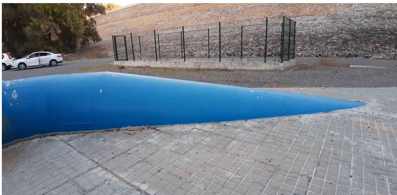
Llegada del conducto del desagüe de fondo secundario a la cámara de válvulas
