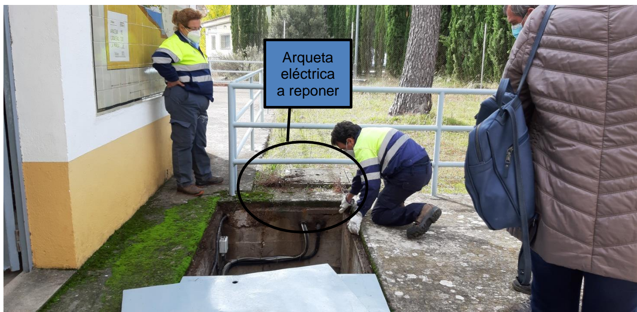
Arqueta delante de la cámara de válvulas del desagüe intermedio, desde el que está previsto realizar la conexión de un nuevo conducto.
