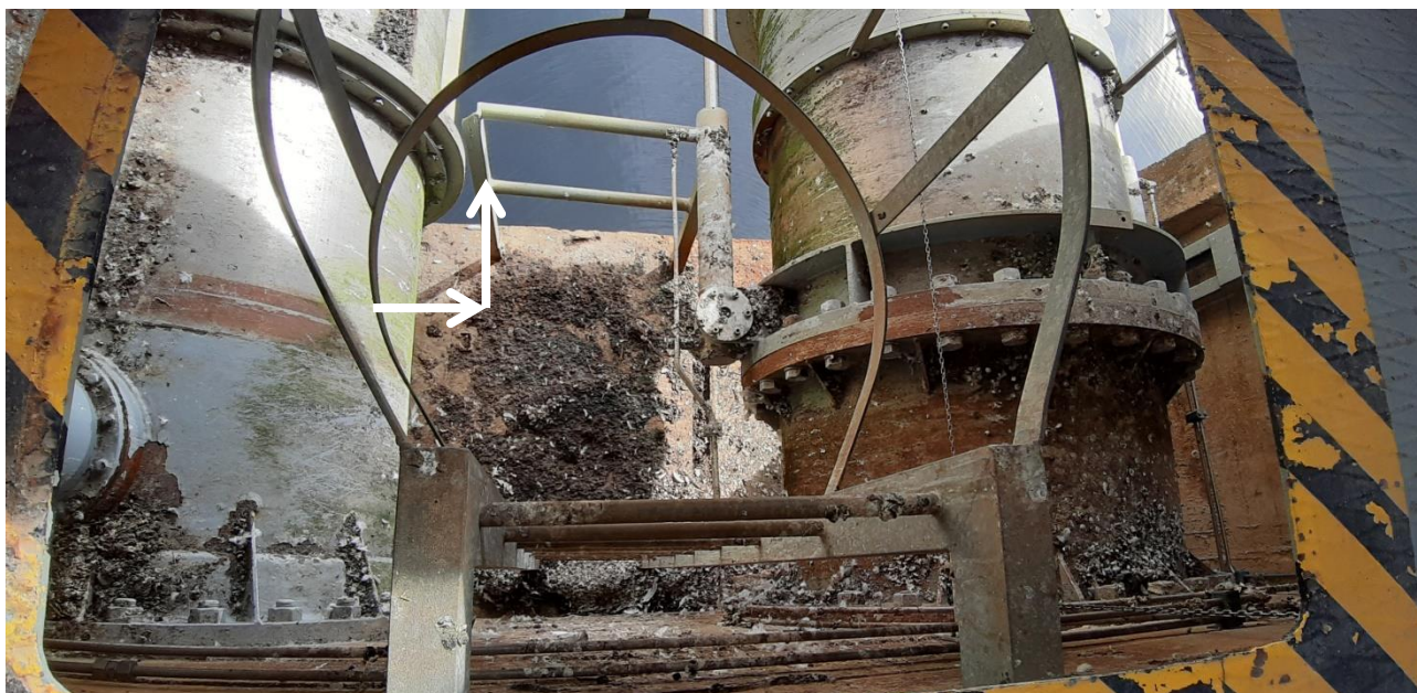
Vista de las compuertas de salida del desagüe intermedio desde la cámara de válvulas. Desde donde se proponía colocar un conducto de desvío para el desagüe ecológico. Las dificultades de acceso frente a la otra propuesta descartan esta opción.
