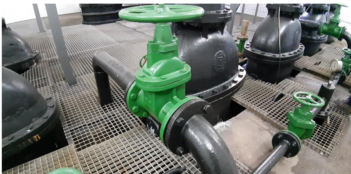
Detalle bypass de las válvulas de seguridad de los desagües de fondo inferiores
