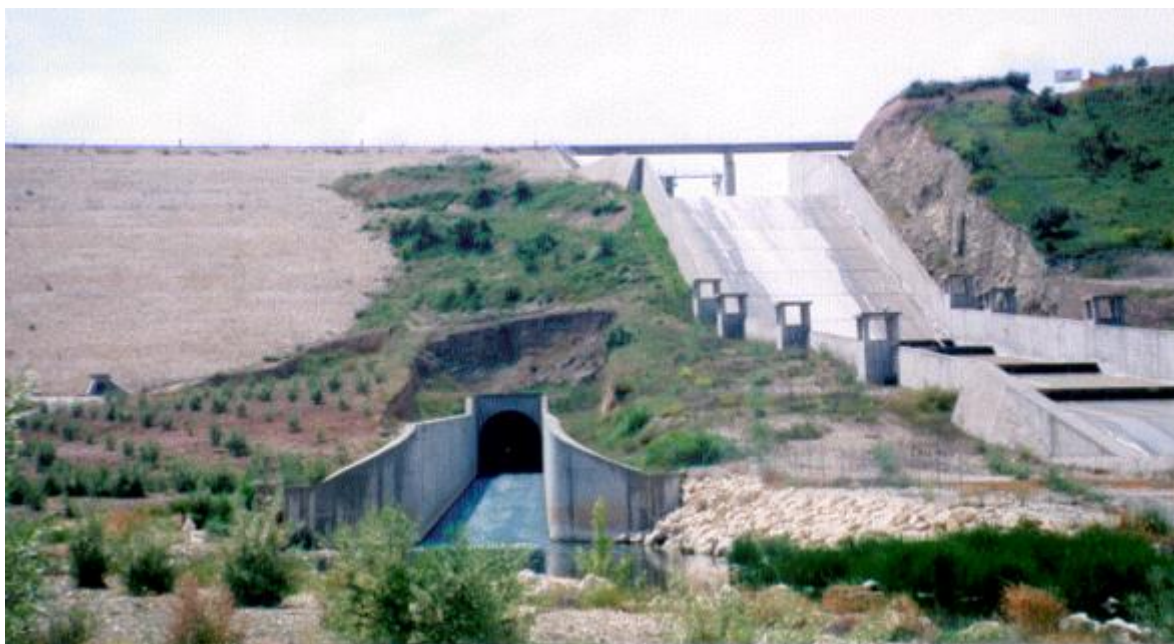
Boquilla de salida del túnel de desagüe de fondo y canal de descarga del aliviadero de superficie
