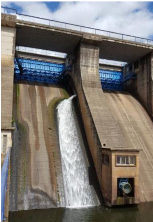
Detalles de ubicación y funcionamiento de los desagües de fondo
