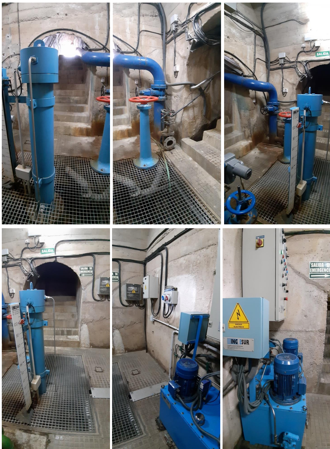
Vista 360° de la cámara de la válvula de seguridad del desagüe de fondo donde se pueden ver el conducto de aducción, el vástago y la escala de la válvula, el motor y el cuadro de control.
