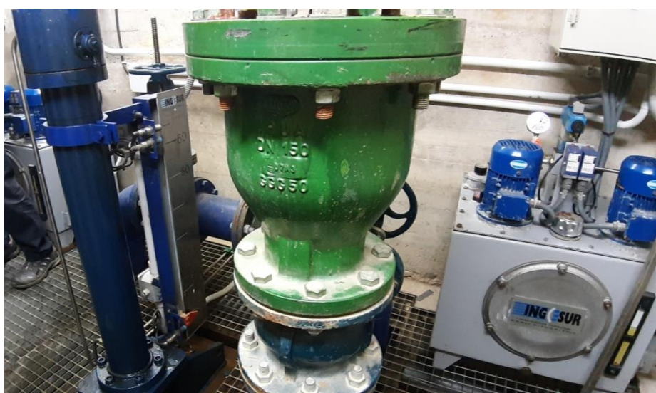
Arriba, by pass y, abajo, ventosa de la válvula de seguridad en el interior de la cámara de válvulas del desagüe de fondo
