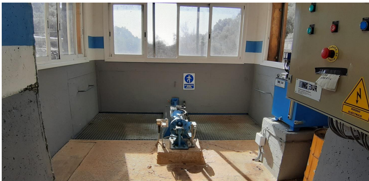
Interior de la cámara de válvulas de regulación de uno de los desagües de fondo
