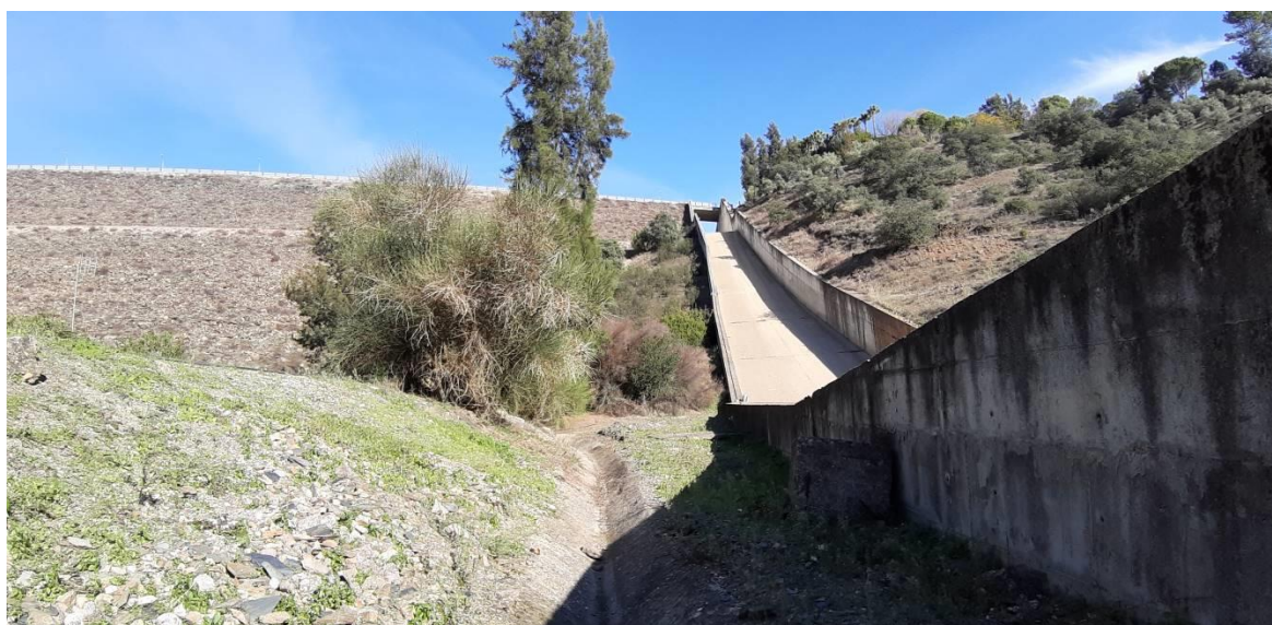
Canal de descarga del aliviadero
