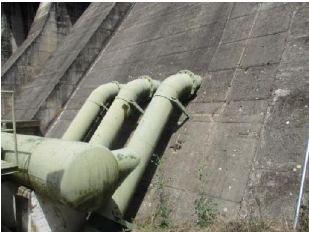
Toma de agua a pie de presa en la margen izquierda
