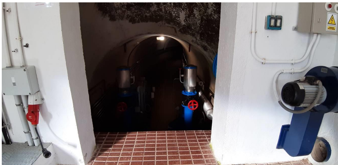
Válvulas intermedias de tramo común al desagüe de fondo en galería
