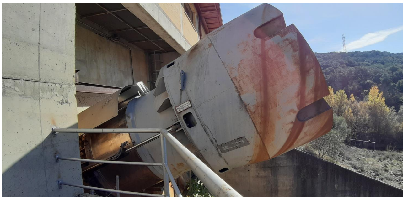
Válvulas de regulación a la salida del desagüe de fondo
