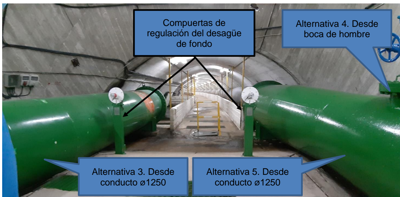
Vista general de la cámara de válvulas desde aguas abajo
