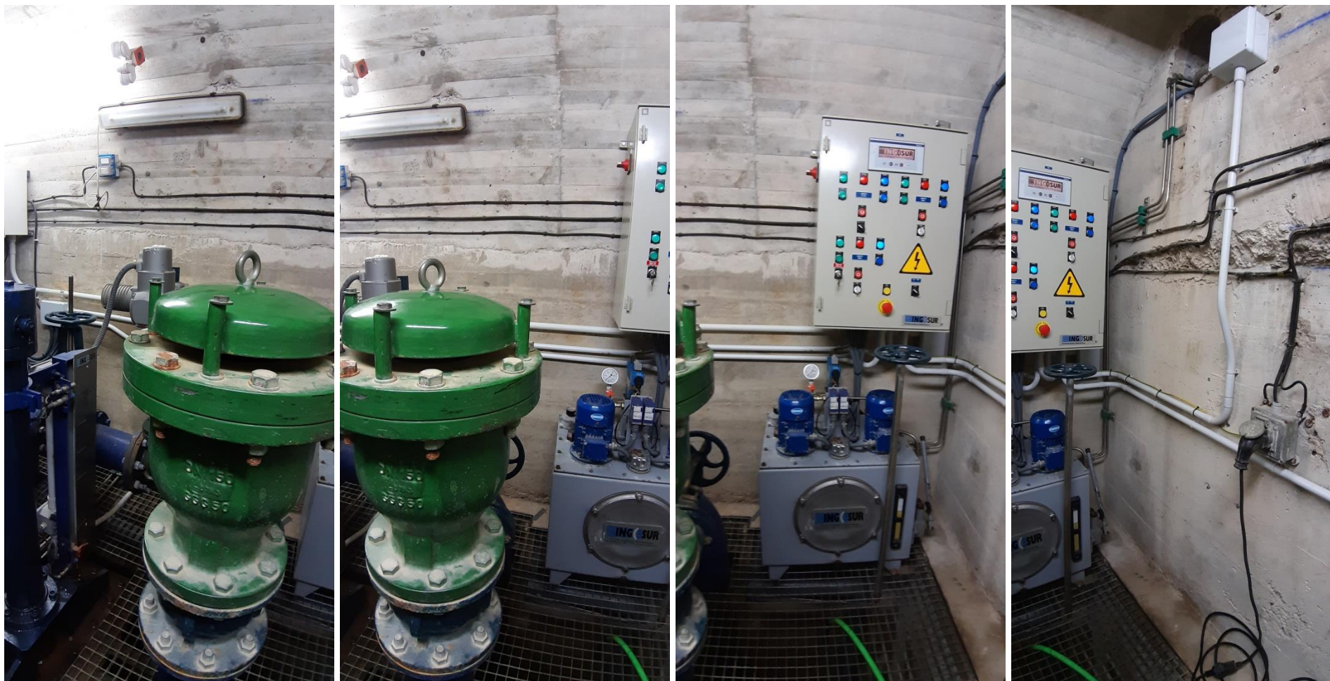
Secuencia del interior de la cámara de válvulas del desagüe de fondo, desde la compuerta de seguridad, al paramento de aguas abajo.
