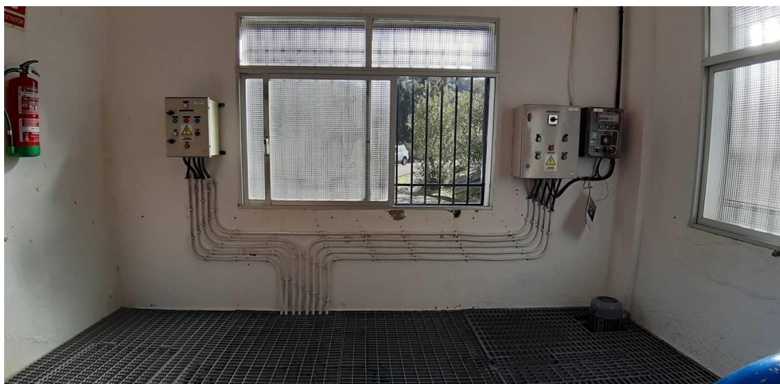
Vista de la cámara en el sentido de salida de los desagües de fondo. Cuadros de control de los desagües
