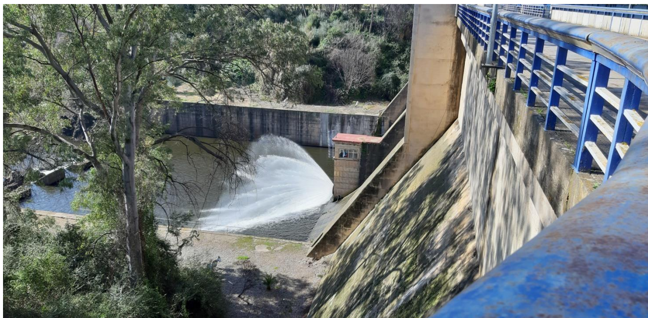
Salida del desagüe de fondo en funcionamiento
