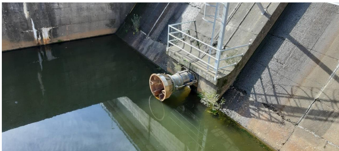
Compuerta de salida del desagüe de fondo
