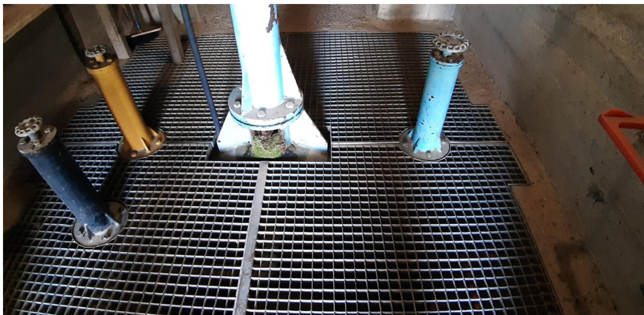
Compuerta de seguridad de la conducción de abastecimiento en la cámara interior
