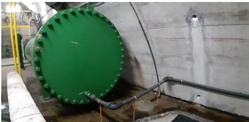
Brida ciega en conducto izquierdo de la toma destinado a regadíos (alternativa 2)
