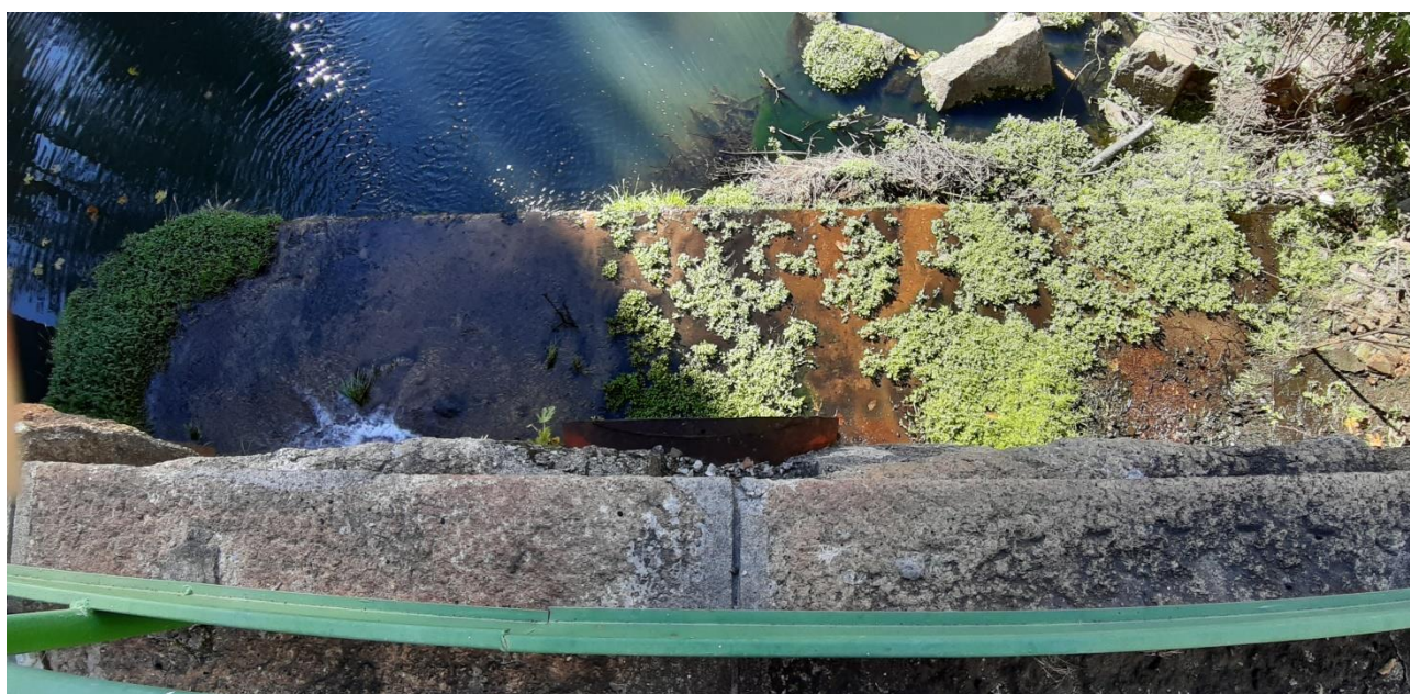
Vista superior de la salida de la Toma a Puertollano que será empleada para el caudal ecológico
