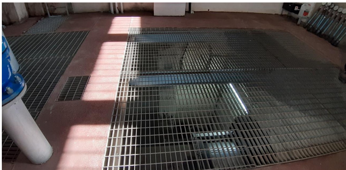
Vista general de los recintos de las válvulas del desagüe de fondo, protegidos con trames.
