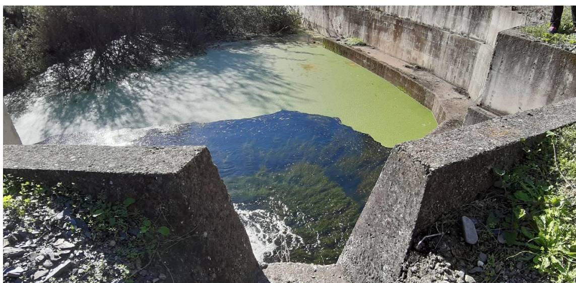
Cuenca amortiguador desde la salida de la cuneta paralela al aliviadero
