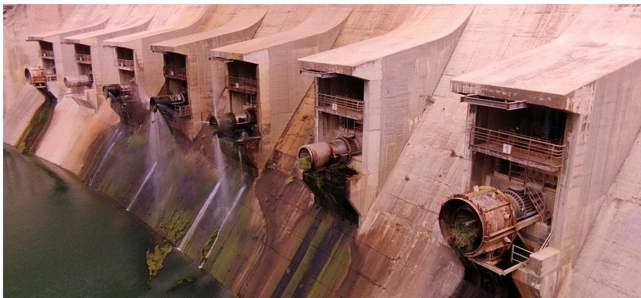
Válvulas de regulación de los desagües de fondo
