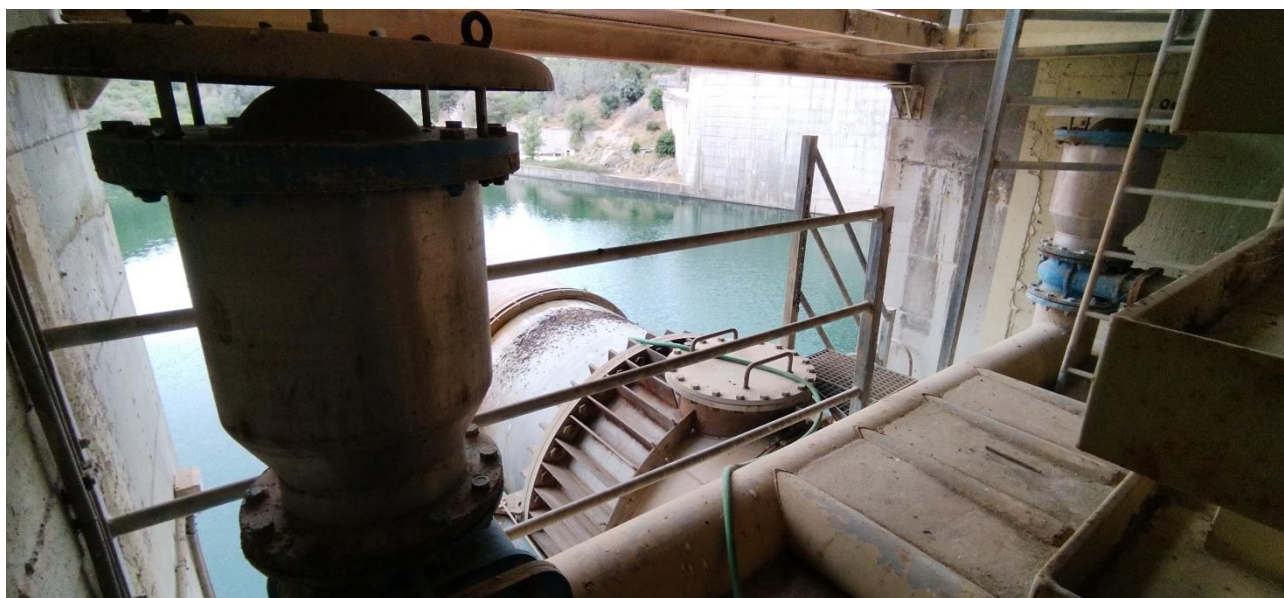
Válvula de regulación y boca de hombre de uno de los desagües de fondo
