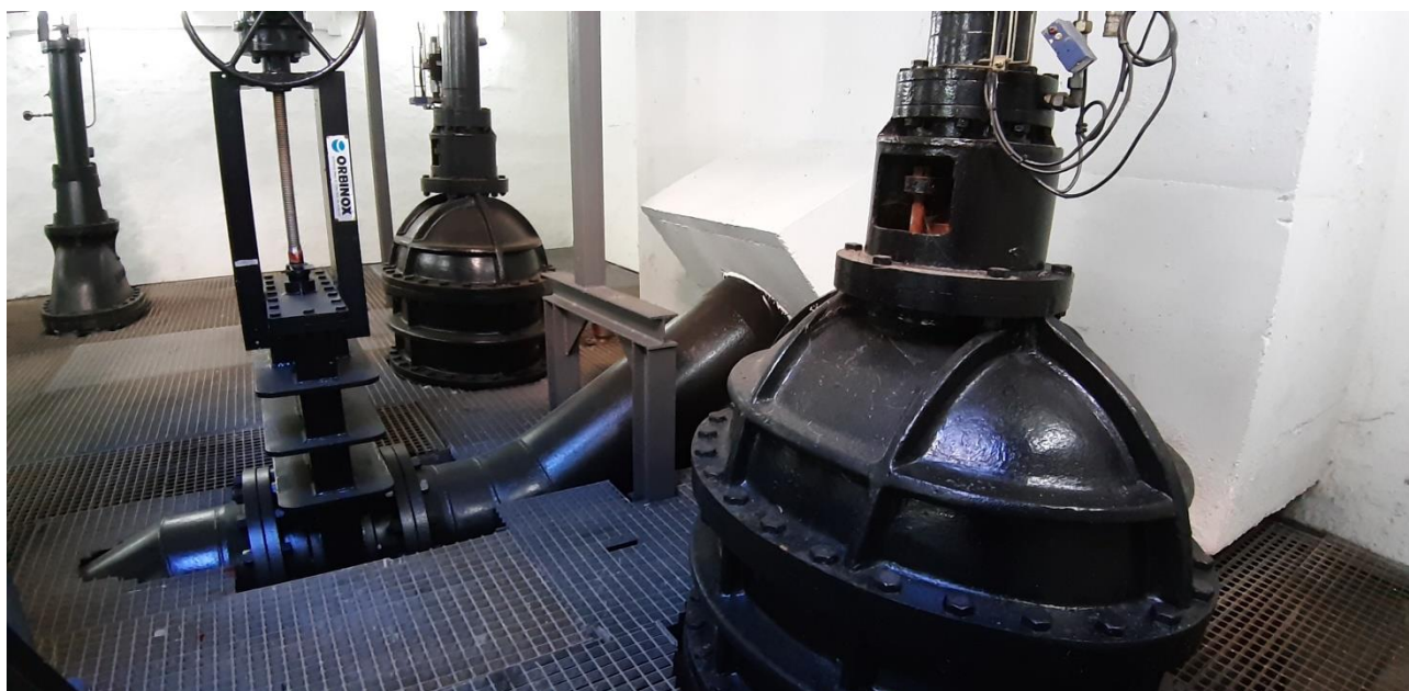
En el centro, válvula de seguridad de la toma de Puertollano. A ambos lados se encuentran las válvulas de regulación de los desagües de fondo inferiores
