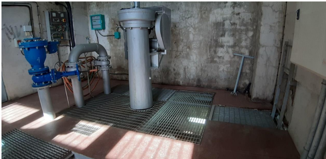
Interior de la cámara de válvulas del desagüe de fondo, válvula de guarda tipo Bureau, bypass y ventosa de la misma.
