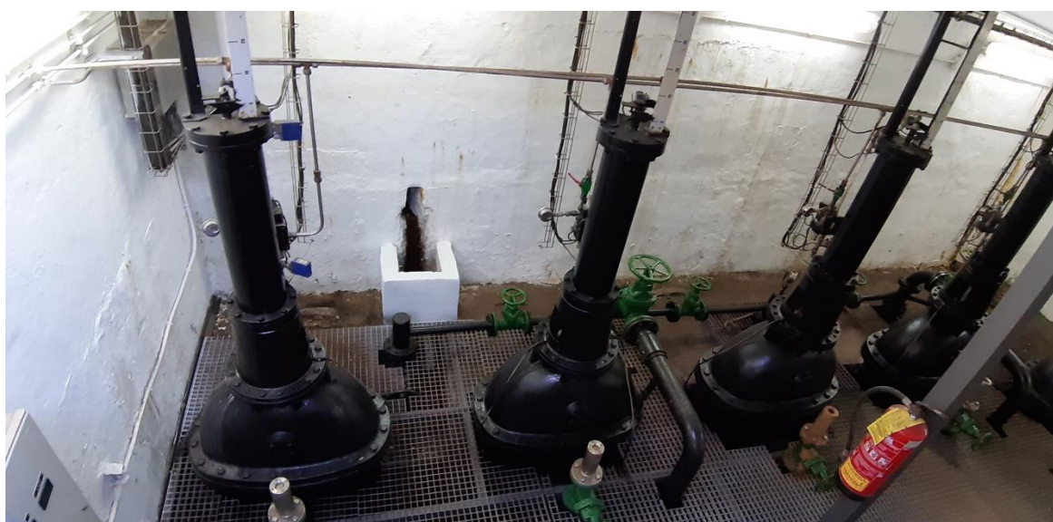
Vistas generales del interior de la cámara de válvulas del desagüe de fondo inferior
