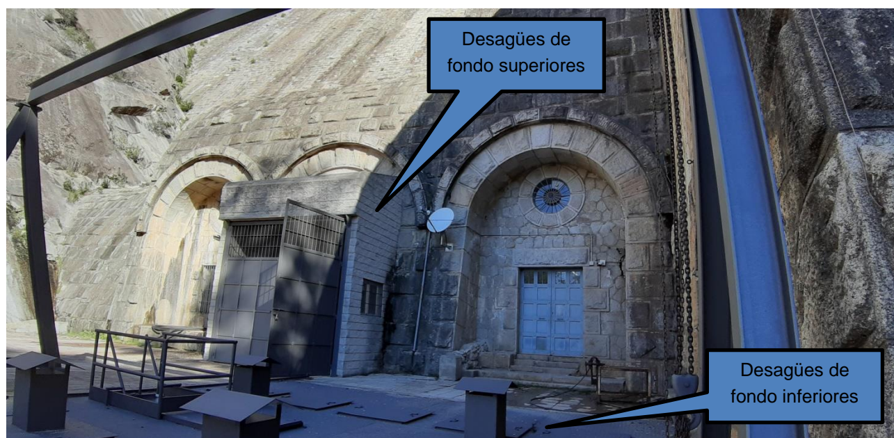
Entrada a la cámara de válvulas de los desagües de fondo superiores e inferiores
