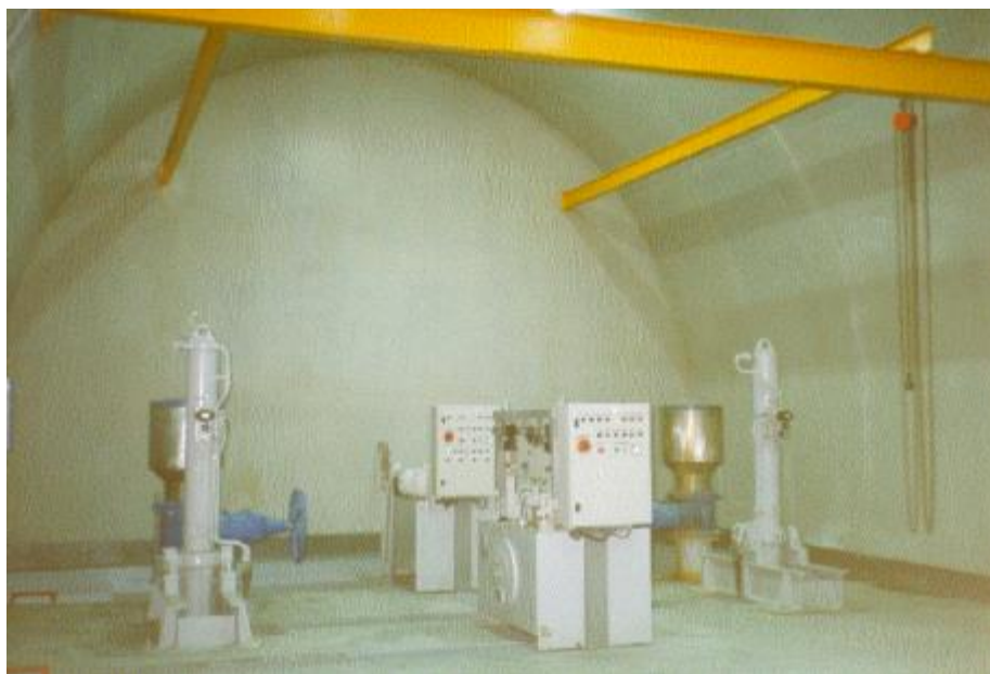
Cámara de válvulas. Compuertas Bureau del desagüe de fondo.
