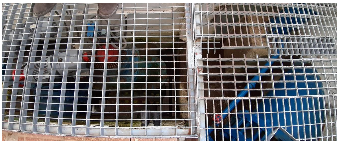
A la izquierda, compuerta del desagüe de fondo y a la derecha, conducto de abastecimiento
