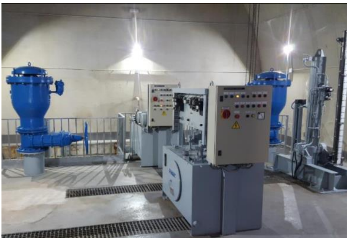
Cámara de válvulas del desagüe de fondo. Compuertas de seguridad.
