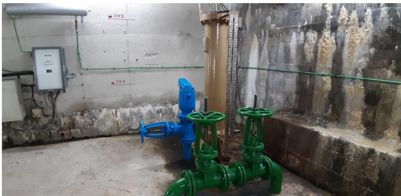
Compuerta de la toma derecha para central hidroeléctrica
