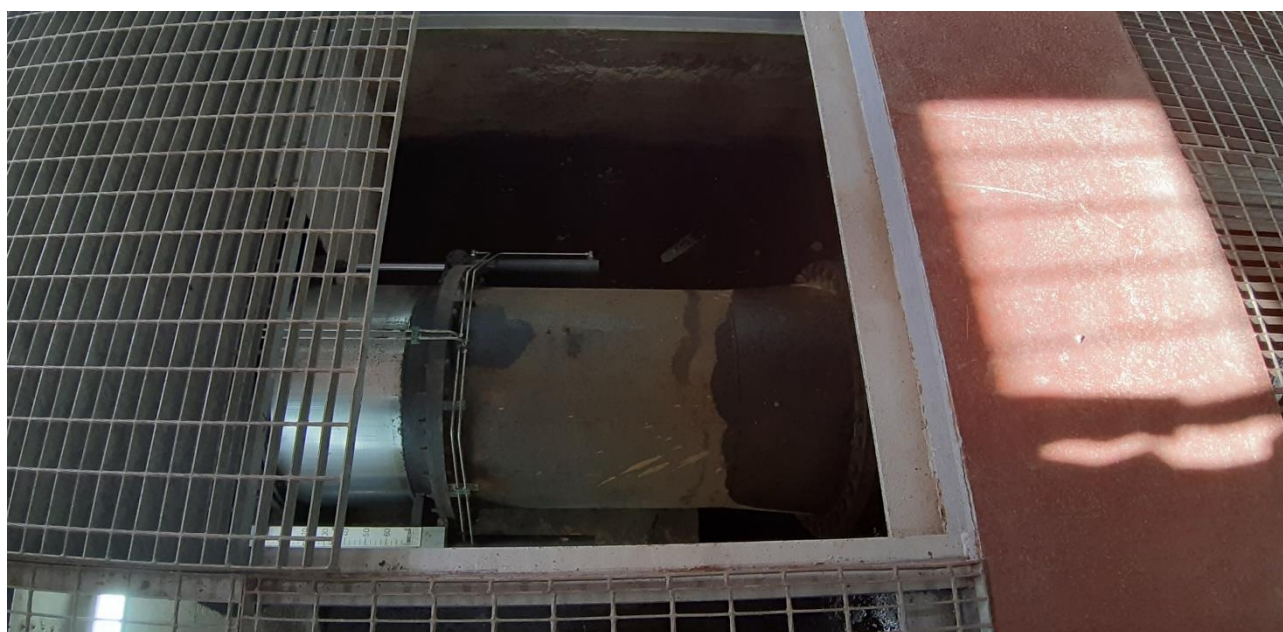
Final de la conducción del desagüe de fondo y válvula Howel Bunguer de salida
