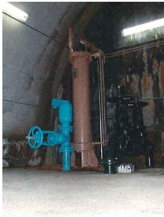
Válvula Bureau del conducto derecho
