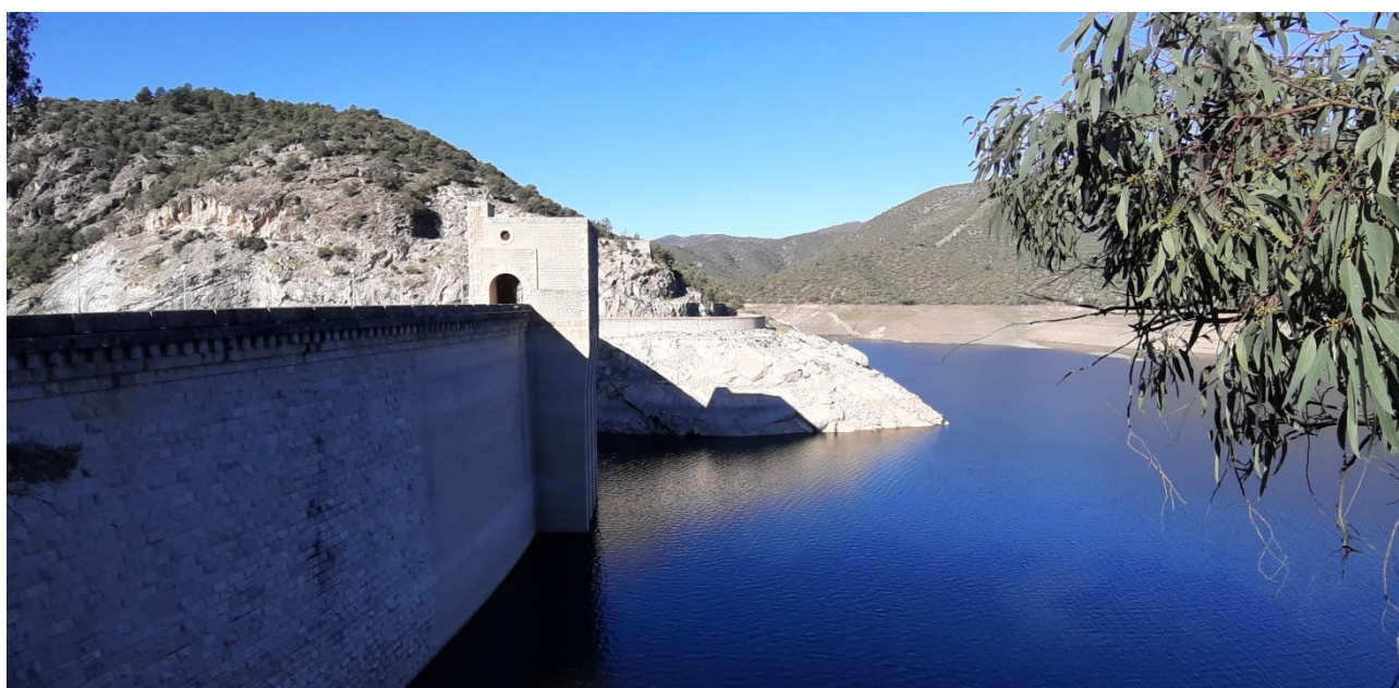
Embalse y paramento de aguas arriba. Torre de manejo de compuertas de las tomas hidroeléctricas
