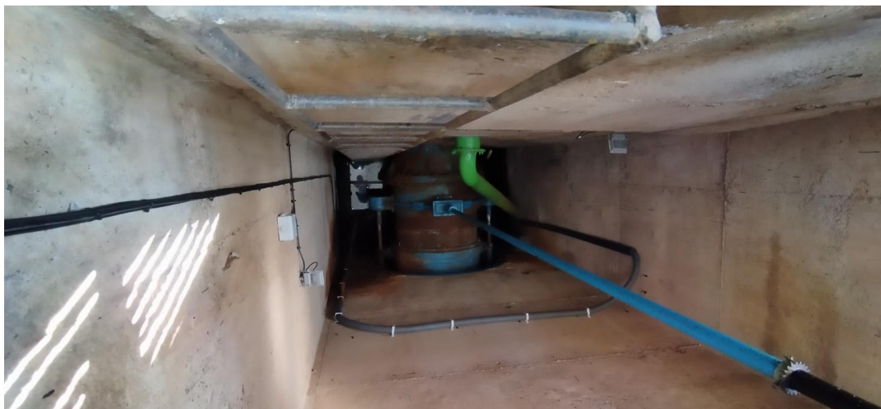
Compuerta de regulación Howell Bunger del desagüe de fondo
