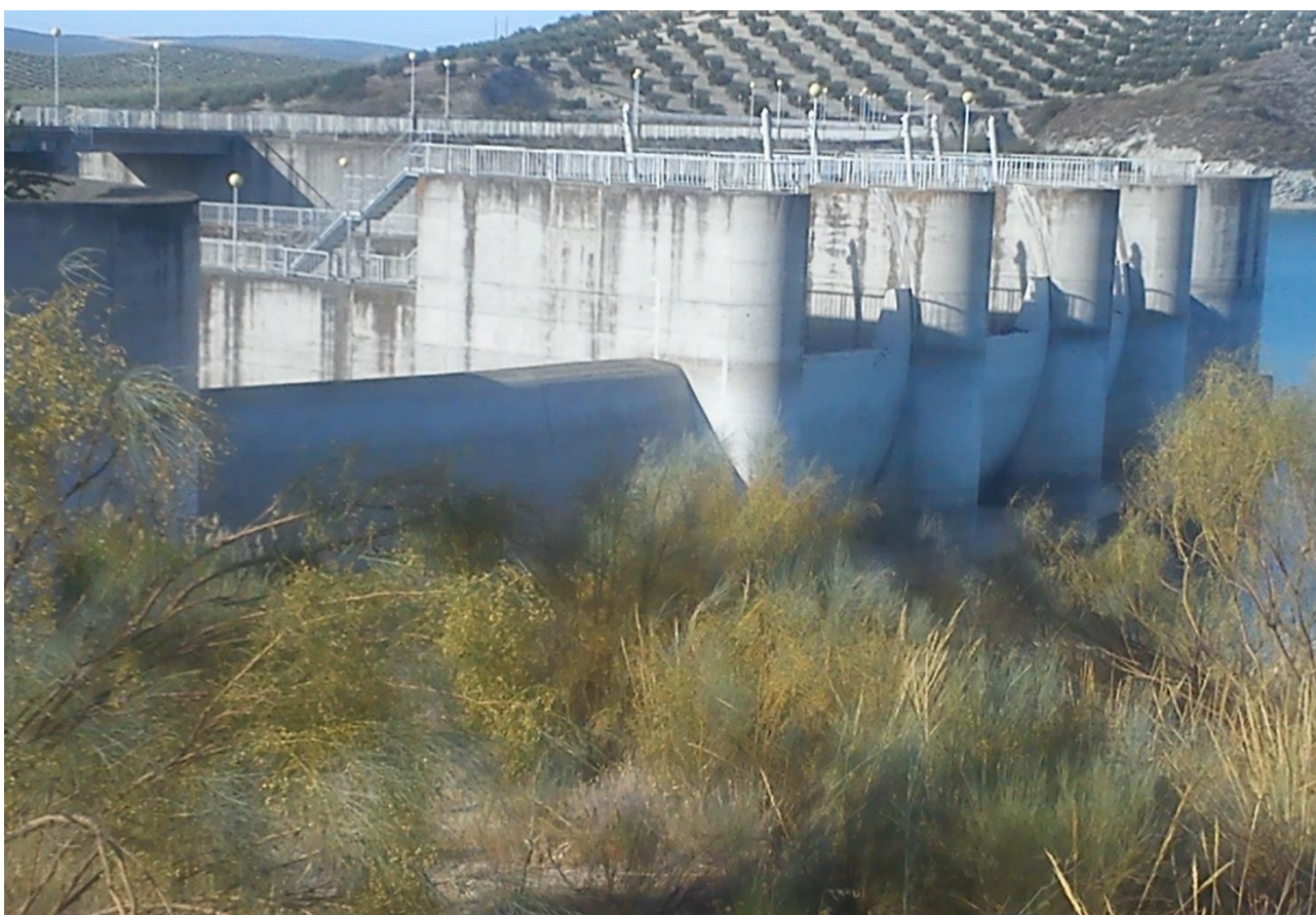
Detalles de las pilas de embocadura del Aliviadero de 2+3 vanos por margen izquierda (2 labios fijos extremos + 3 con compuertas Taintor-radiales o de segmento, en los 3 vanos centrales)
