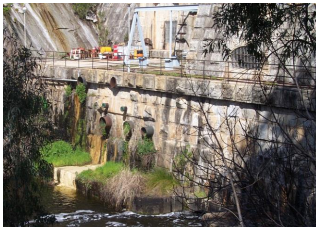
Vista de las salidas del desagüe de fondo
