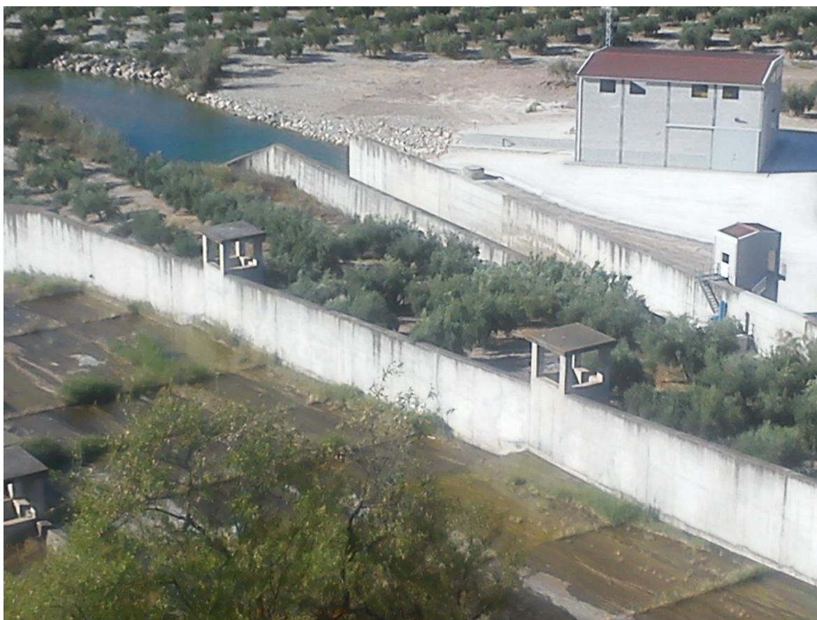
Detalles de la nave de aprovechamiento hidroeléctrico al fondo a la derecha (aguas abajo) y en primer término de las casetas de las galerías de aireación de la rampa del aliviadero
