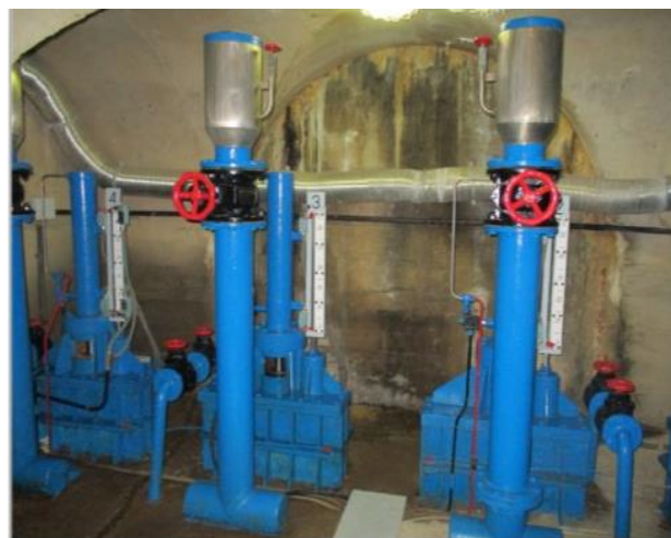
Cámara de válvulas del desagüe de fondo
