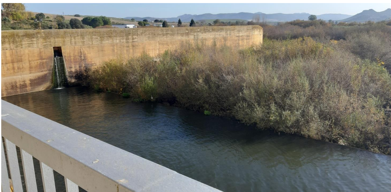
Cuenca amortiguador de salida al cauce
