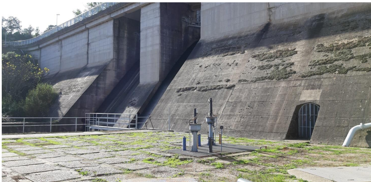
Paramento aguas abajo de la presa. Arqueta de válvulas de la toma de abastecimiento
