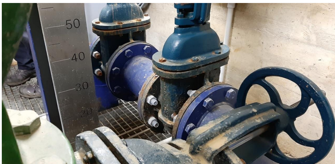
Arriba, by pass y, abajo, ventosa de la válvula de seguridad en el interior de la cámara de válvulas del desagüe de fondo
