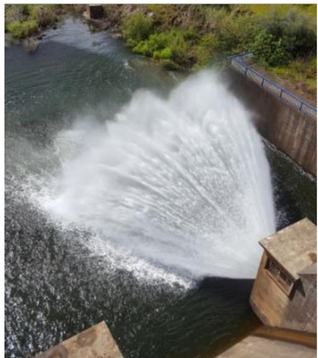
Detalles de ubicación y funcionamiento de los desagües de fondo
