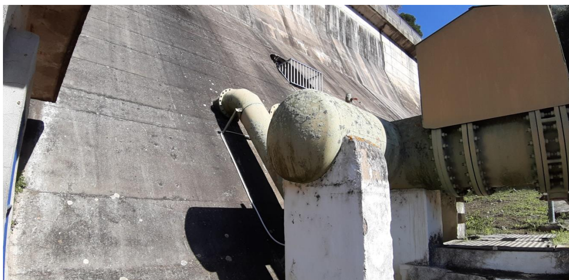
Detalle de los conductos de abastecimiento que se unen en un conducto común en el exterior de la presa
