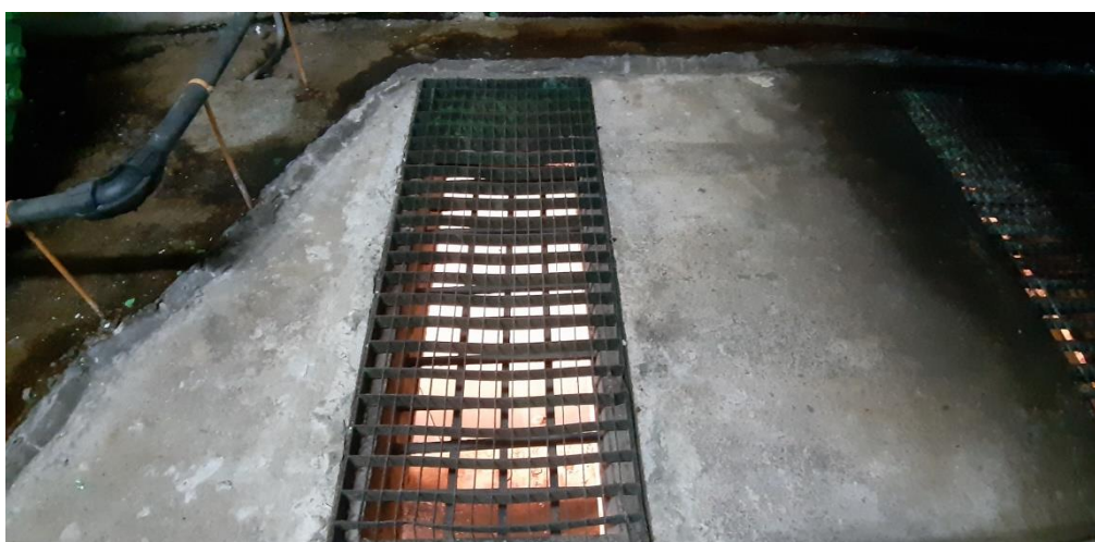
Abertura de la solera, protegida por tramex, delante de la brida ciega. Debajo se encuentra el canal de descarga del desagüe de fondo
