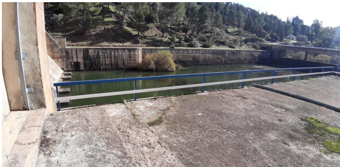
Plataforma de cubierta del canal de descarga del desagüe de fondo y cuenco amortiguador de la presa
