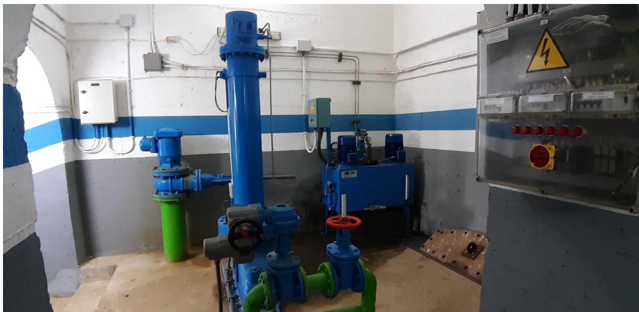
Cámara de válvulas de seguridad del desagüe de fondo derecho
