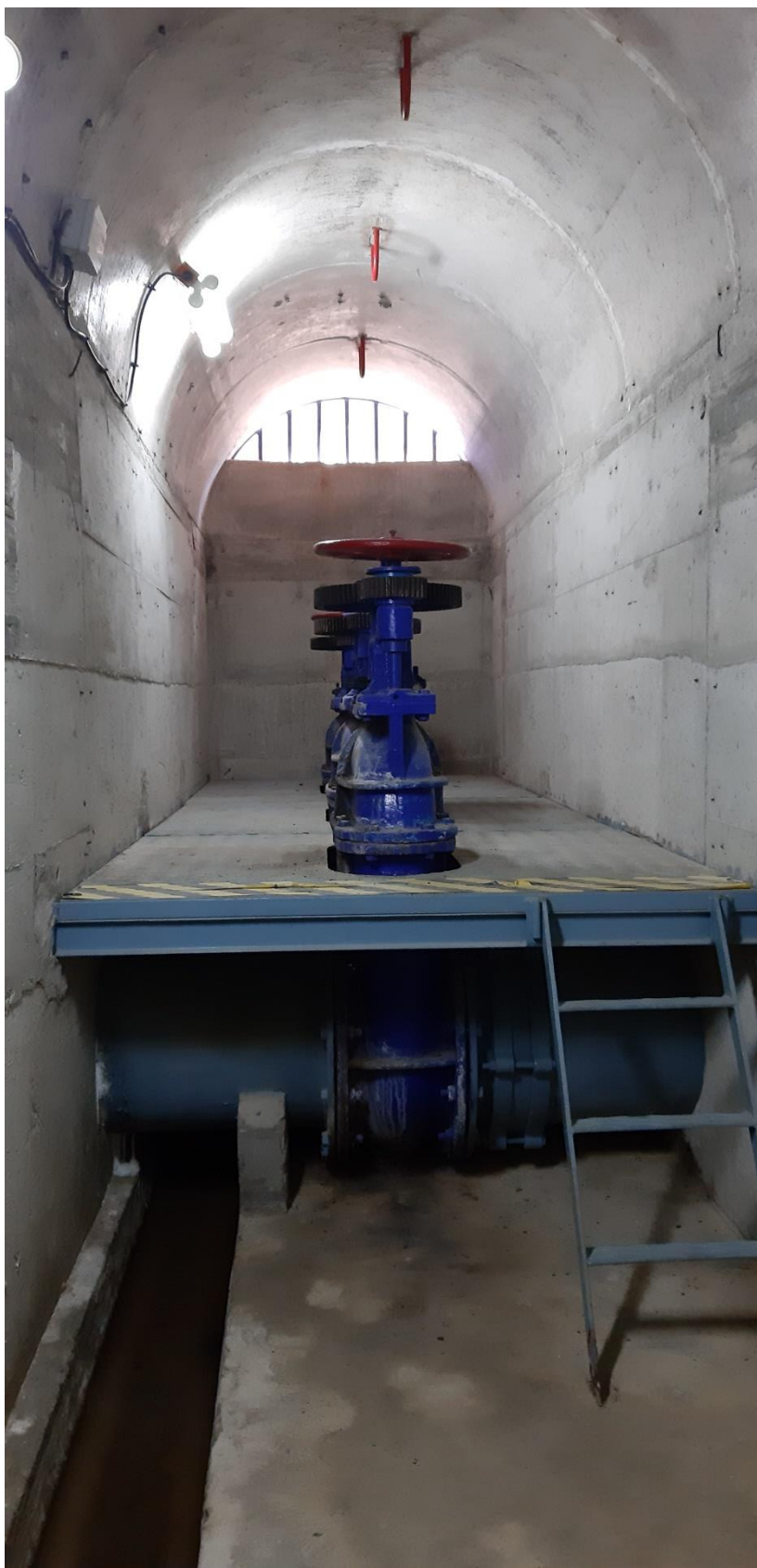
Cámara de válvulas de la toma de abastecimiento
