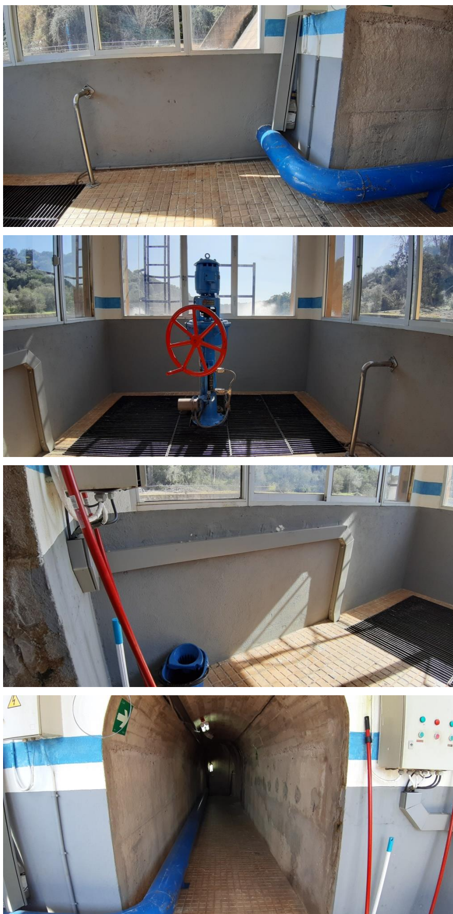
Vista 360º de la cámara de la válvula de regulación del desagüe de fondo donde se puede ver el conducto de aducción, y la galería por la que discurre, así como el volante para maniobrar la válvula de regulación.
