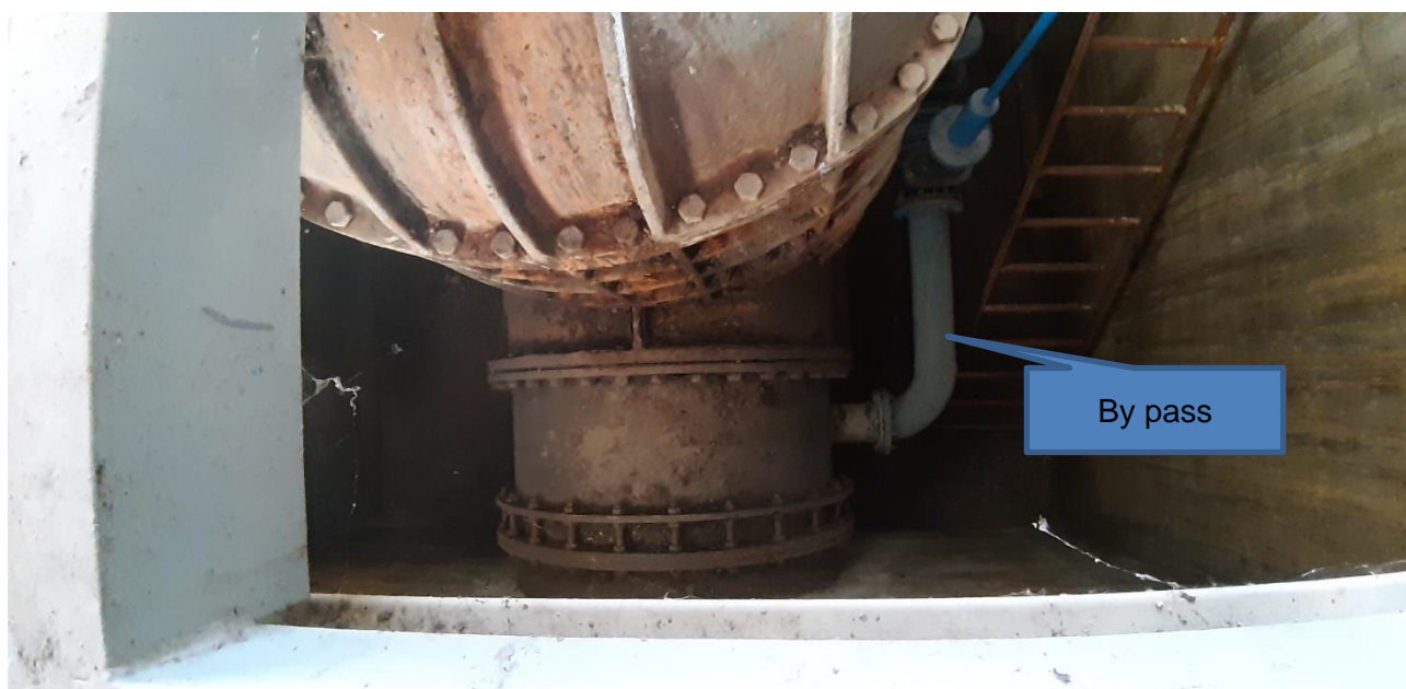
Vista aguas arriba de la compuerta de seguridad
