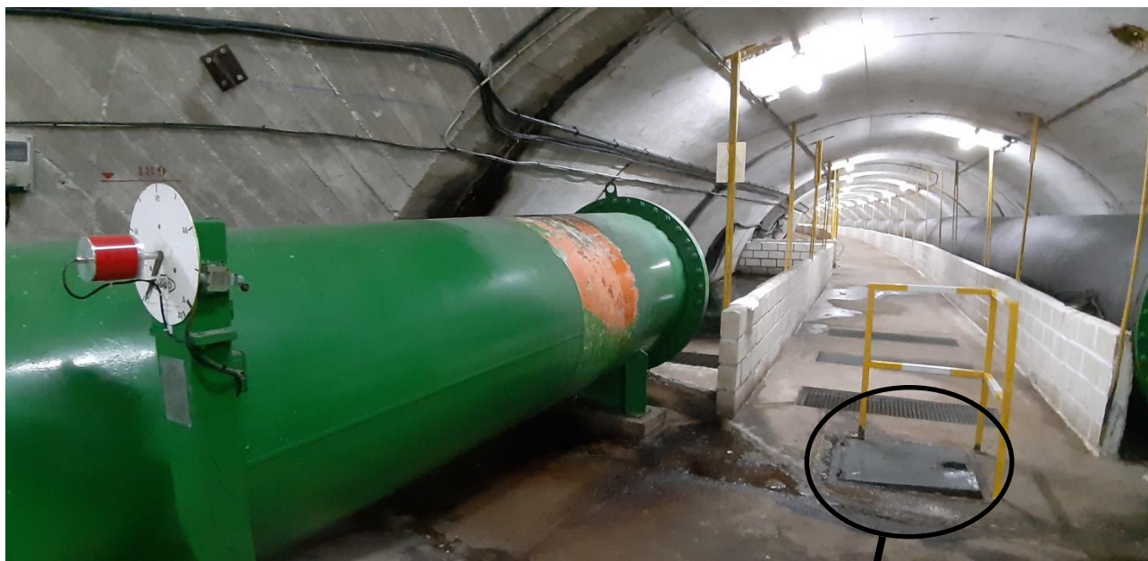
Acceso al canal del desagüe de fondo, desde cámara de válvulas
