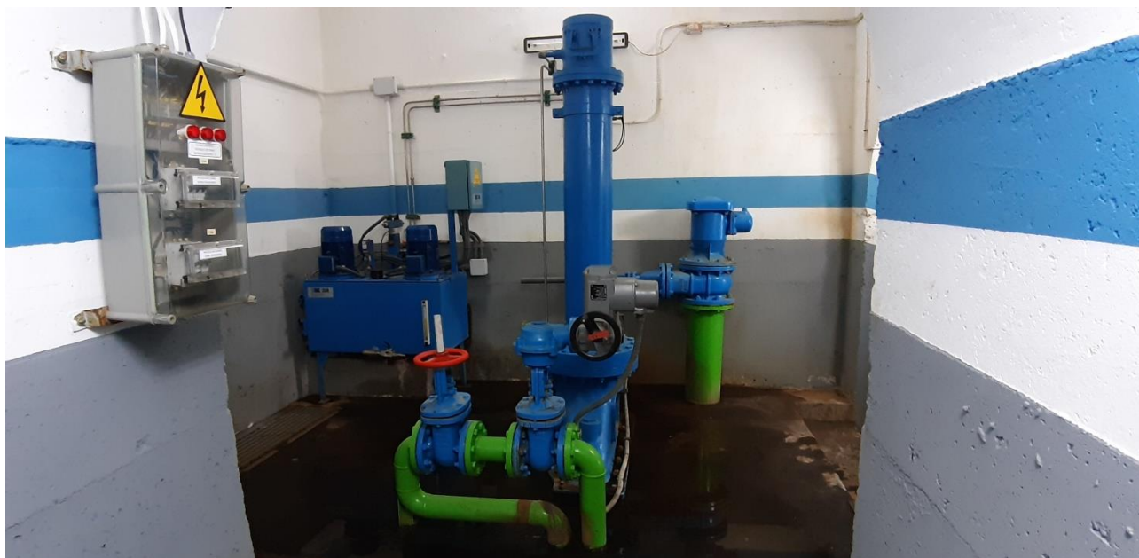
Cámara de válvulas de seguridad del desagüe de fondo izquierdo
