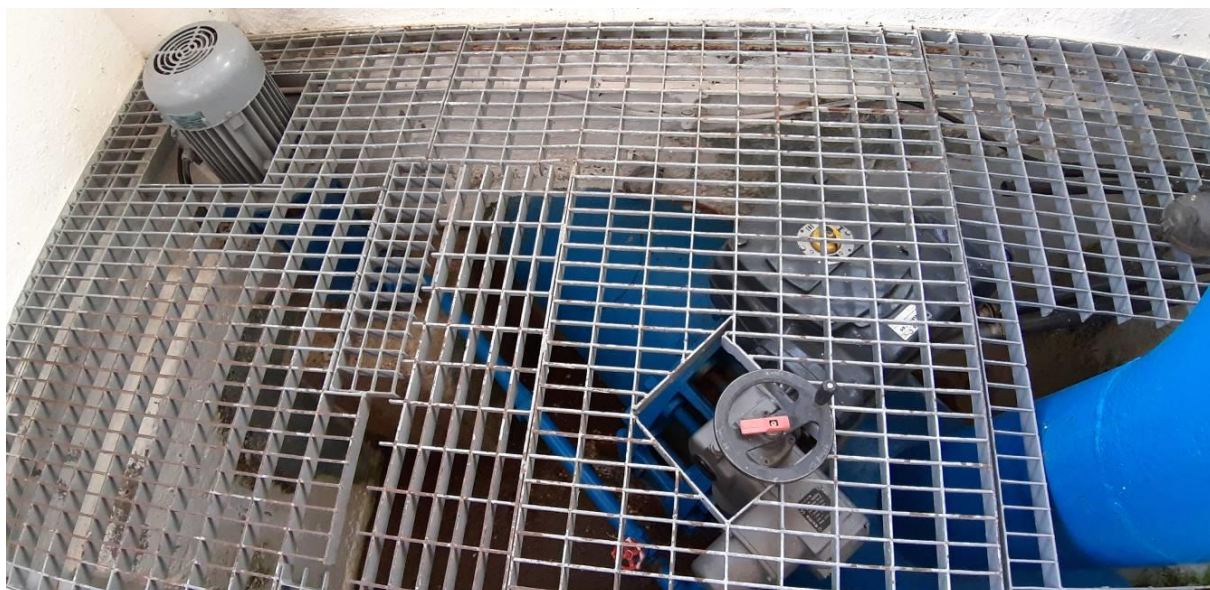
Derivación del conducto de abastecimiento al bombeo
