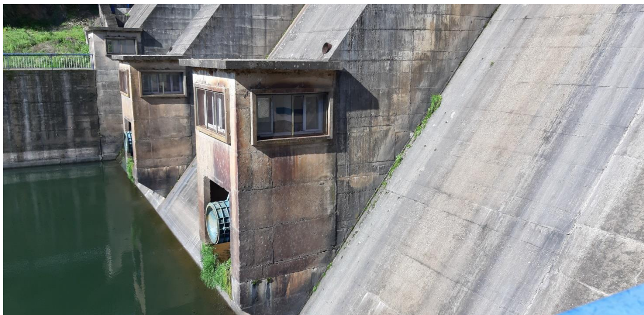
Exterior de la cámara de válvulas de regulación de los desagües de fondo
