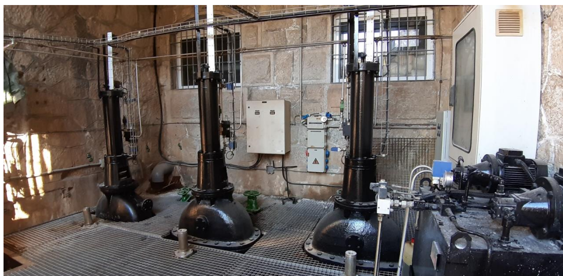
Válvulas de los desagües de fondo superiores en el interior de la cámara de válvulas.
