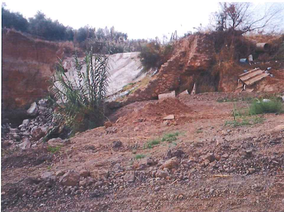
8 - Vista del desprotegido estribo derecho.
