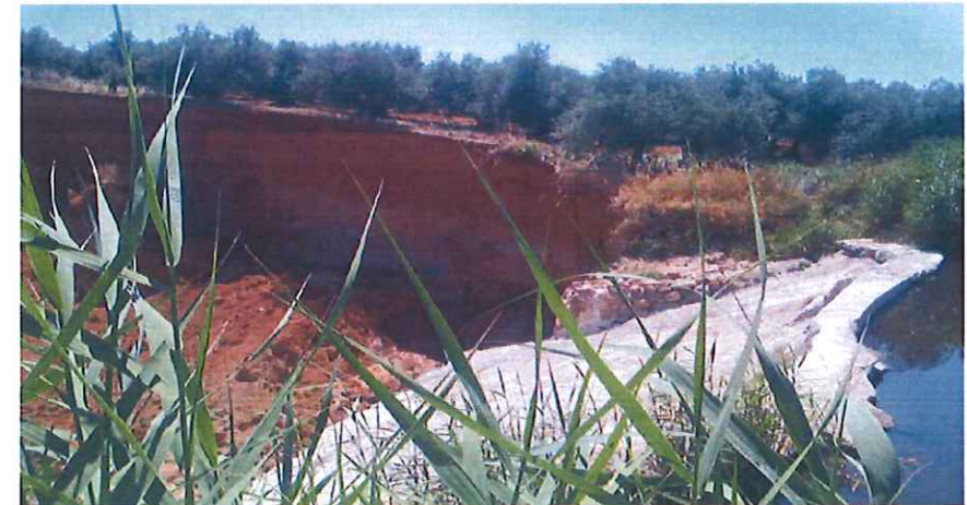
5 –Azud, tanto el pié como el estribo derecho están descarnados y necesitan ser reparados.
