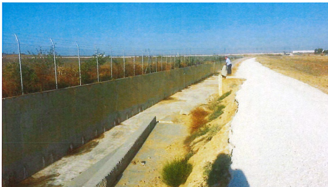
Figura 5: Tramo de muro desplomado completamente
