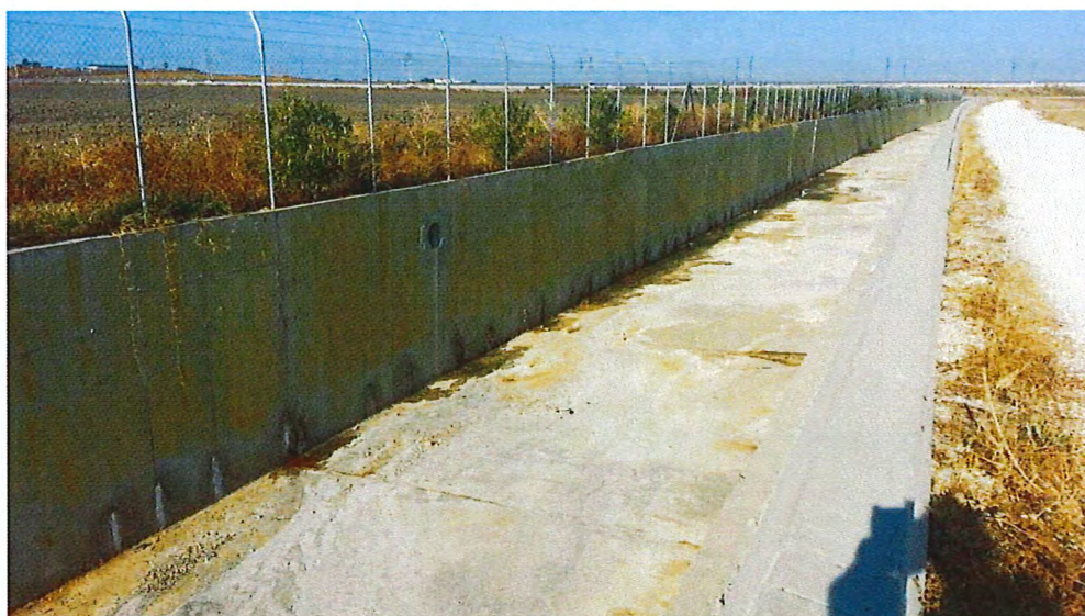
Figura 8: Zona con intensa corrosión de armaduras en la junta de unión del muro con la solera.
